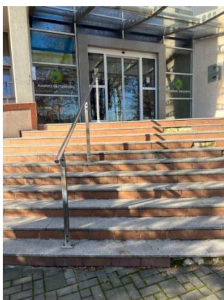
Obr. 29 Hlavní vstup a schodiště
