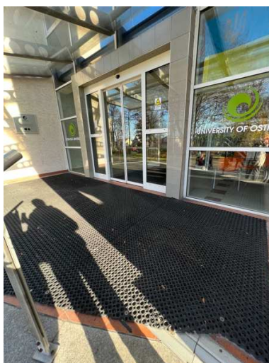
Obr. 31 Hlavní vstup a manipulační plocha
