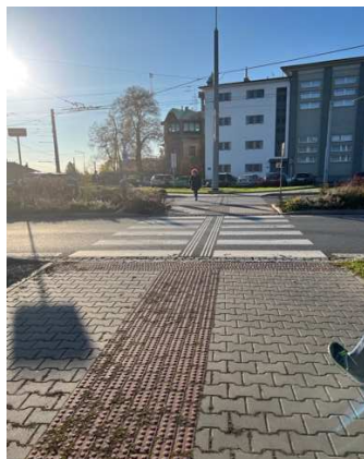
Obr. 28 Přechod pro chodce ulice Hladnovská
