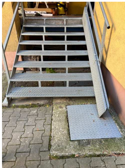
Obr. 14 Schodiště a rampa
