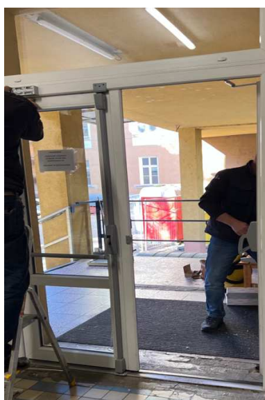
Obr. 15 Hlavní vstup do budovy
