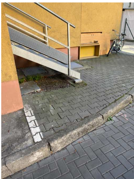
Obr. 13 Schodiště a rampa
