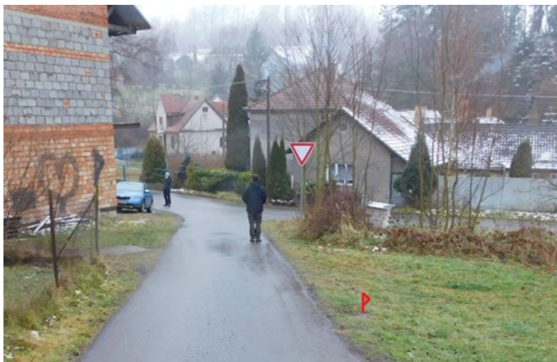
Obr. 5 Foto situace stavby Horní Štěpánov (pohled od stožáru č. 125 směrem k novostavbě (nalevo))
