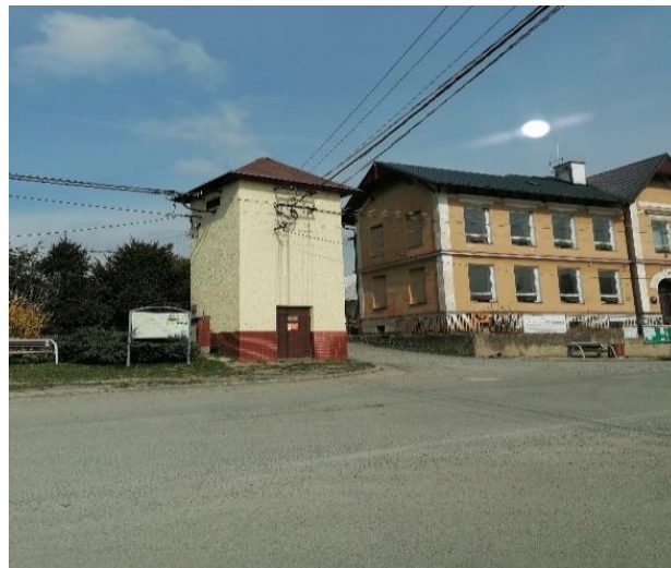
Obr. 8 Zděná věžová trafostanice
