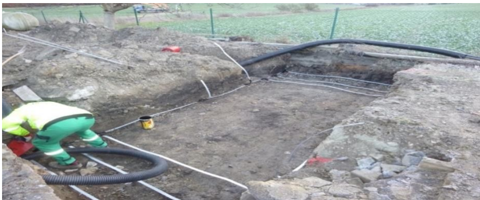
Obr. 16 Uzemňovací soustava
