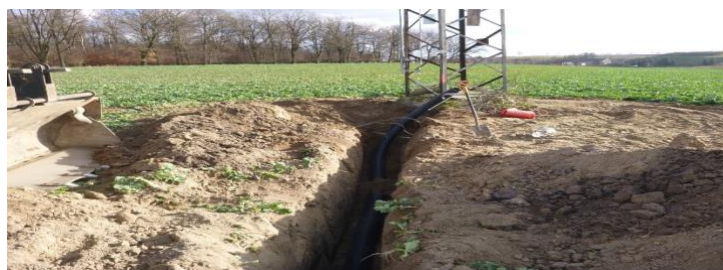
Obr. 9 Trasa kabelového vedení
