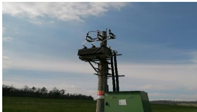
Obr. 7 Sloupová trafostanice
