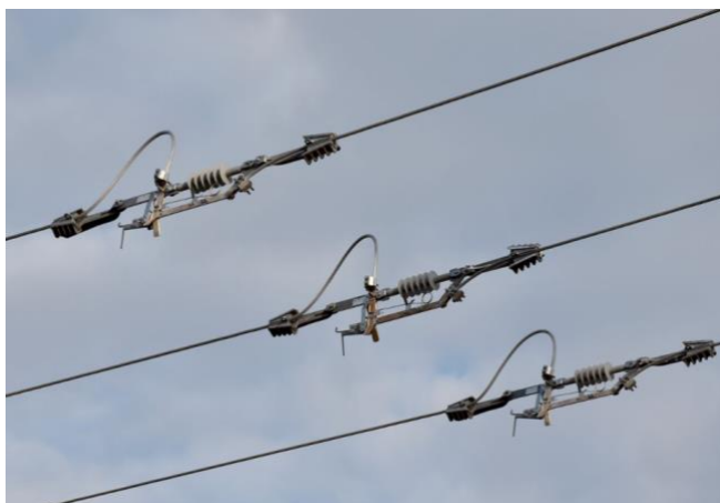
Obr. 5 Odpojovač Flr
