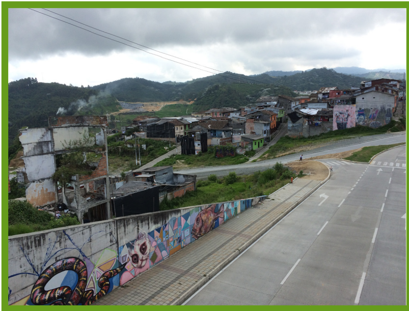
Ilustración 2. Macroproyecto San José, Manizales. Construcción Avenida Marcelino Palacio sobre la Zona Mixta de revalorización de predios. Foto Acebedo, 2016.
