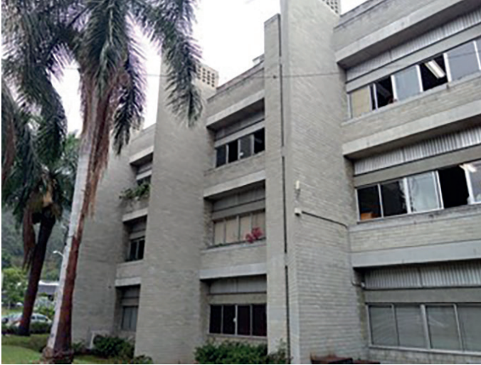
Figura 2. Bloque 19A, Universidad Nacional de Colombia, Sede Medellín. Mampostería en concreto con agregados reciclados. Fuente: Bedoya, 2018.
