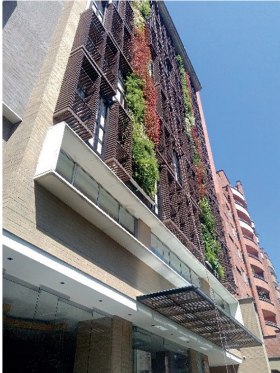
Figura 3. Terra Biohotel, Medellín, Colombia. Edificio construido con bloques de concreto reciclado, iluminación y ventilación natural de habitaciones. Fuente: Bedoya, 2016.
