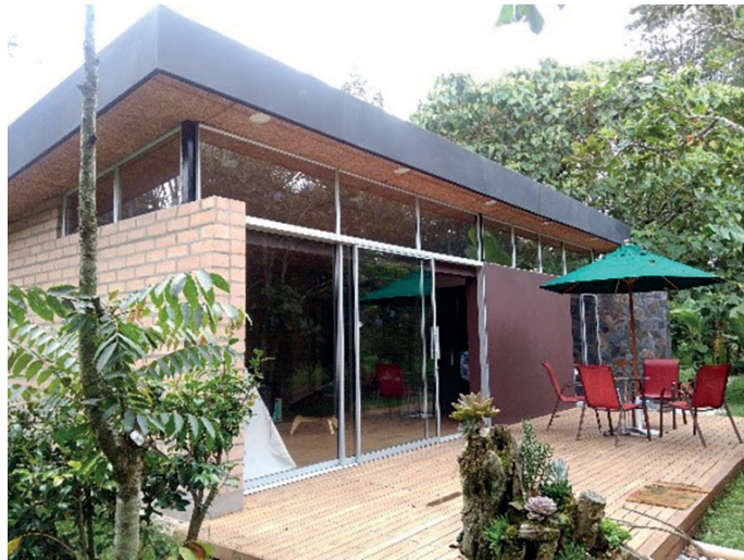
Figura 1. Vivienda Nasua. Rionegro, Antioquia. Mampostería en bloques de suelo cemento BSC; energía solar y reúso de aguas lluvia. Fuente: Bedoya, 2017.
