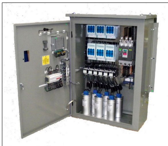
Figura 15. Banco de condensadores
