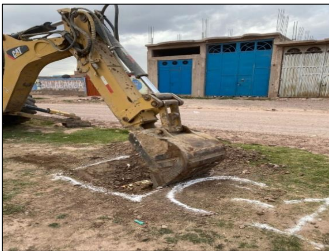
Figura 46. Realizando la calicata 1 con retroexcavadora.
