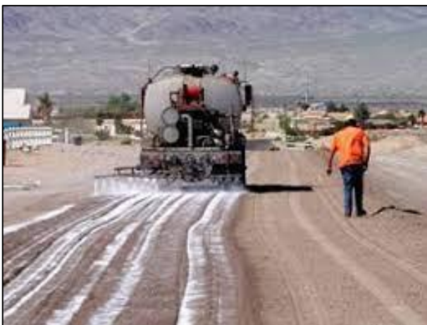
Figura 27. Estabilización de suelo en trocha carrozable. Fuente: National Lime Association [LIME] (65).
