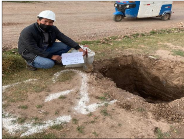
Fotografía 04: Apertura de la calicata 02
