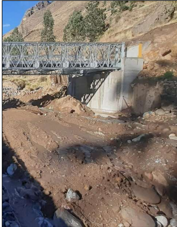
Foto 1. Vista del Puente Fortaleza del tramo 0+00 al 0+60.00m
