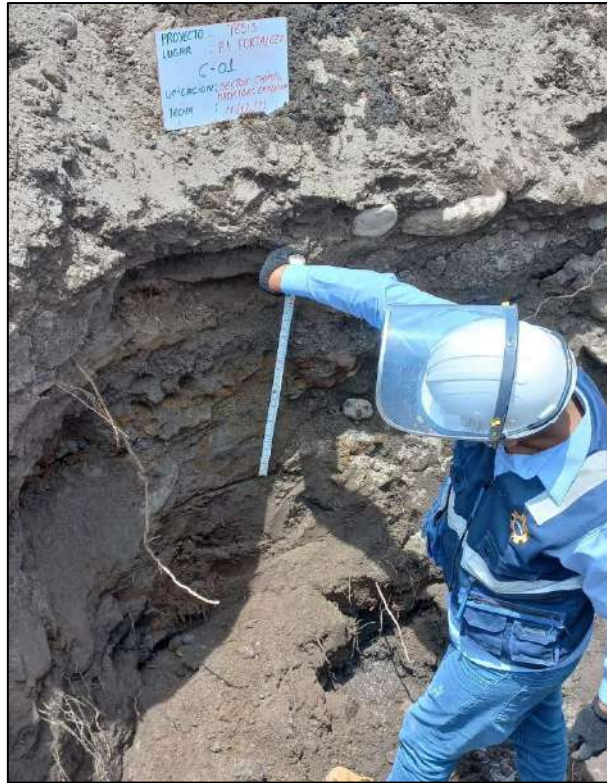
Foto 3. Vista de la excavación de la calicata 1 con una profundidad de 2.00 m
