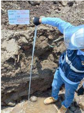
Figura 19. Excavación de la calicata 01– Prof.=2.10 m en el tramo 0+00 – 0+25.00
