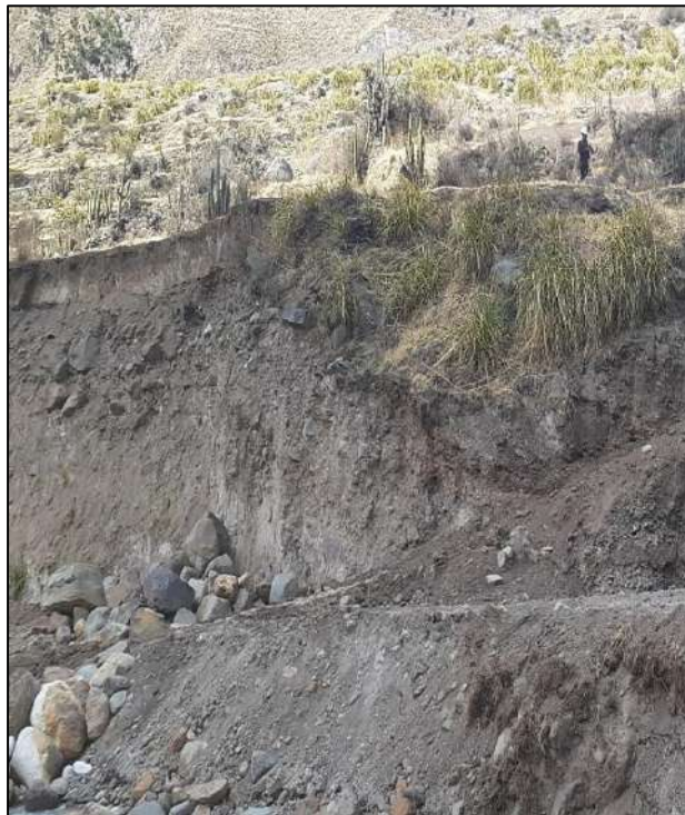
Foto 2. Vista de la altura del talud de 3.00 m
