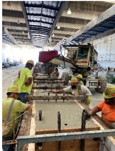
(d) Surface completion
