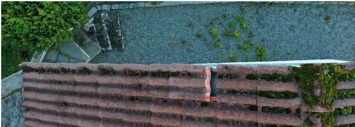
Figur 31: Visuell inspeksjon av tak ved bruk av drone (Frantzen, 2021).
