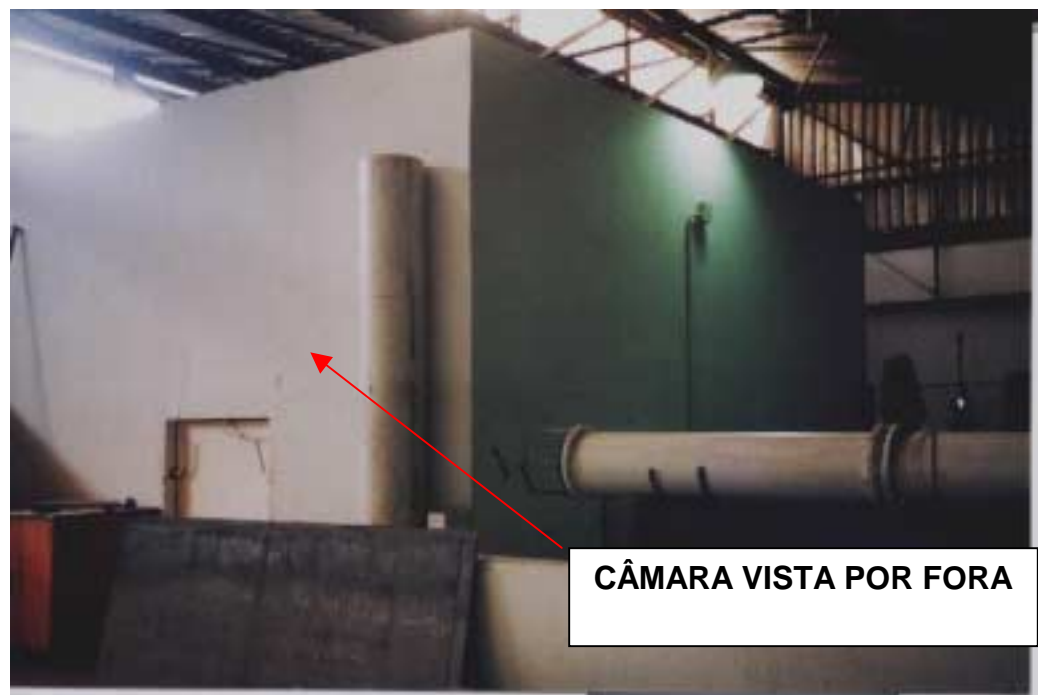
Figura 5.6 – Câmara vista do lado de fora
