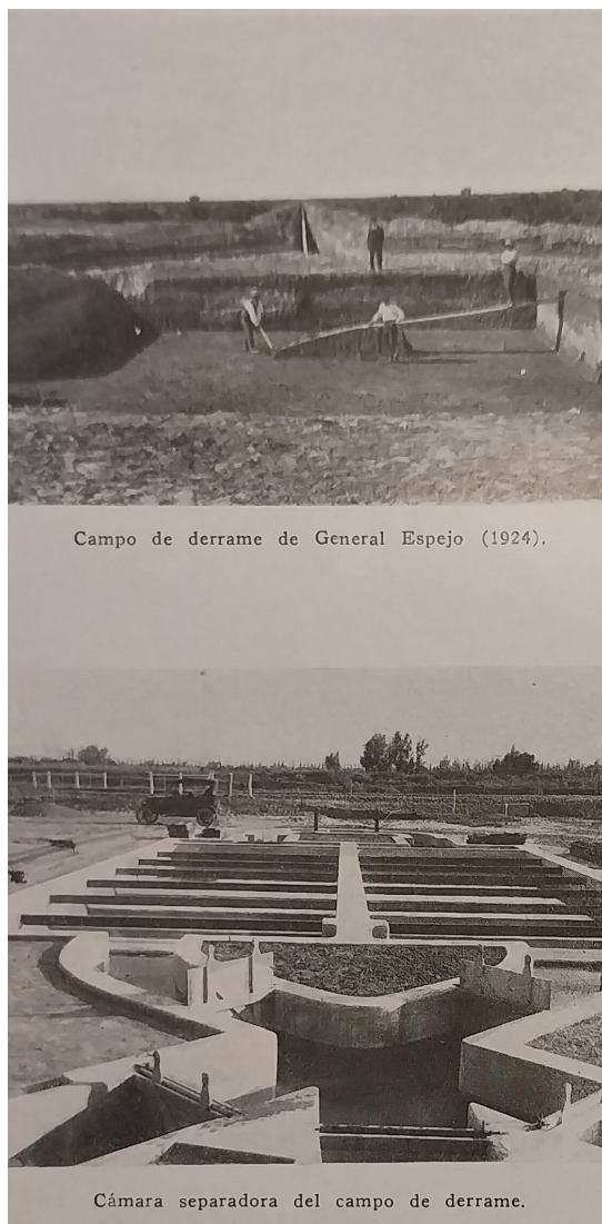
FIGURA 11 Campo de derrame en General Espejo y Cámara separadora en 1924 OSN, Memoria del Directorio 1937, p.356.
