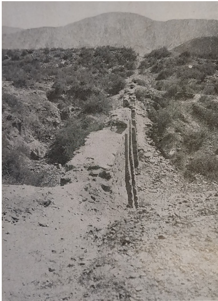
Restos del acueducto del Challao. Puede verse el eje del conducto.
