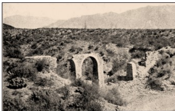
FIGURA 1.1 Restos del acueducto del Challao 1876-1880. OSN, Memoria del Directorio 1937
