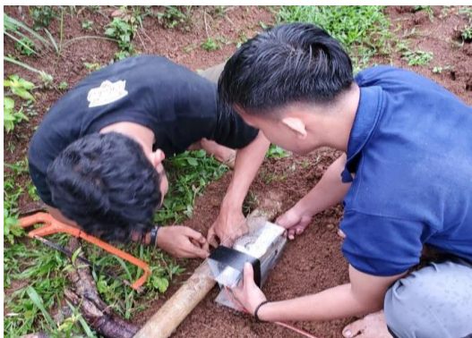
Gambar 9. Pemasangan MOV pada Pipa
