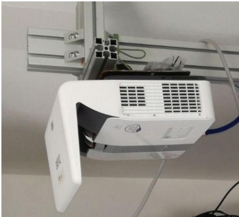
FIGURA 4.1.1.3 – VISTA LATERALE DELL’INSTALLAZIONE DEI VIDEOPROIETTORI DELLA VR-CAVE DI SWING:IT
