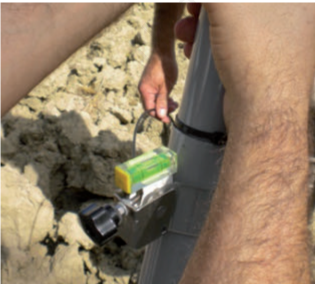
Figura 10. Messa in bolla del palo.
