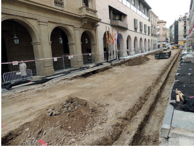
Fig. 2. Zanjas laterales de pequeñas dimensiones en los Porches de Galicia.
