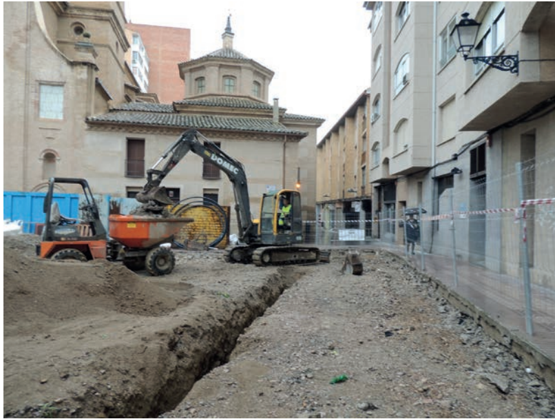
Fig. 11. Zanja que recorría el lateral sur de la plaza de Santo Domingo. En ella se identificaron varias inhumaciones en fosa simple, y en los metros finales, casi en la embocadura de la calle Perena, se recogieron dos estelas discoideas.
