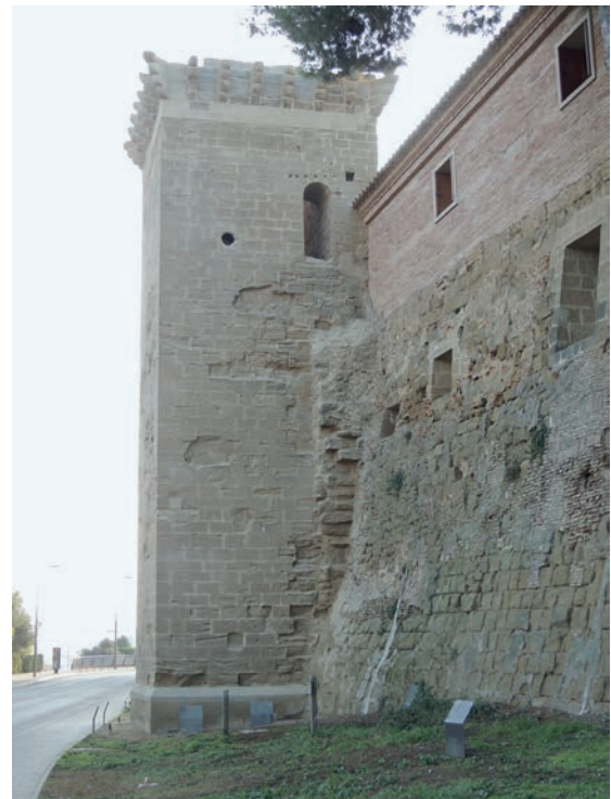
Fig. 24. Vista del lateral oeste del torreón.
