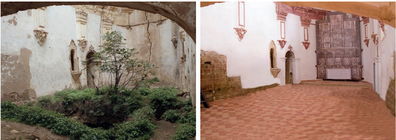
Fig. 3. Vista de la nave y el presbiterio de la iglesia de Montearagón antes y después de la restauración. (Fotos: Asociación de Amigos del Castillo de Montearagón)
