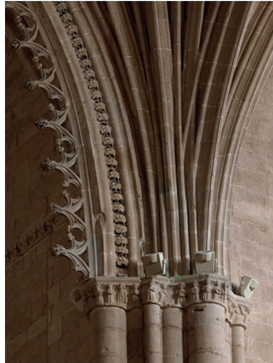
Fig. 11. Arranque del arco de embocadura con crestería en el ábside de la catedral de Huesca y cornisa con esculturas.
