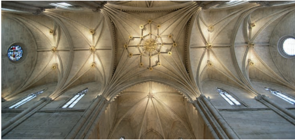
Fig. 9. Bóvedas del presbiterio y nave del crucero de la catedral de Huesca (Juan de Olotzaga, 1498-1500).
