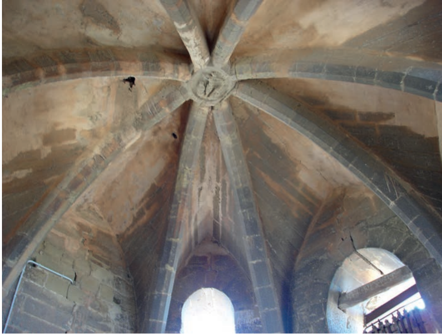
Fig. 3. Bóveda de la cuarta planta de la torre campanario de la catedral de Huesca (Pere Jalopa, circa 1423-1424).
