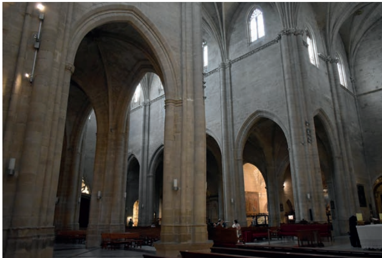
Fig. 15. Vista del cuerpo de naves de la catedral de Huesca desde el transepto.
