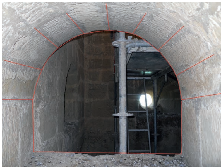
Fig. 28. Detalle del interior de una de las cañoneras. Al fondo se observan las situadas en los lienzos norte y este.
