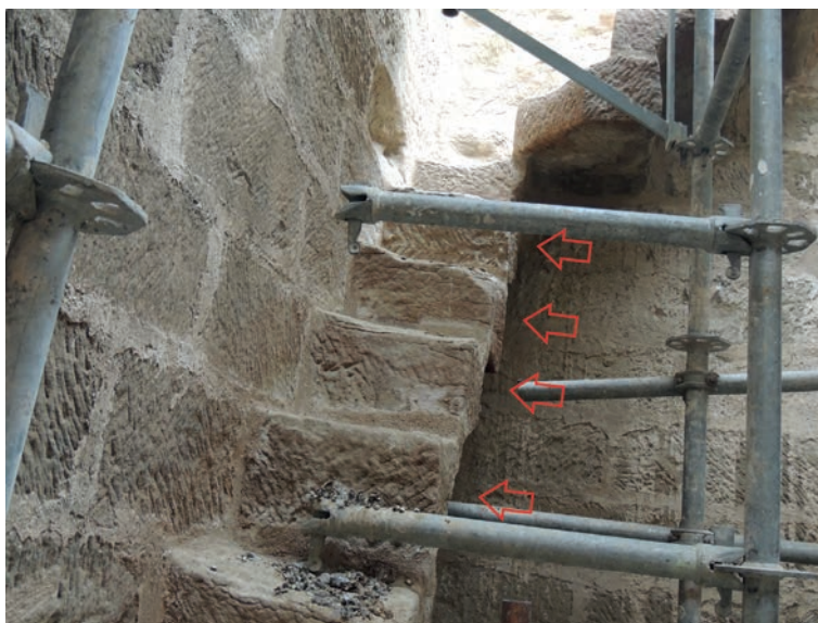
Fig. 29. Detalle de las escaleras que desde el interior permitían la comunicación entre el único piso existente y el superior, ocupado por el matacán.
