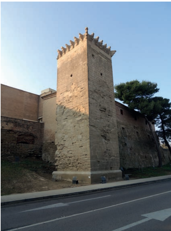
Fig. 23. Vista general desde el noreste del torreón tras su consolidación.
