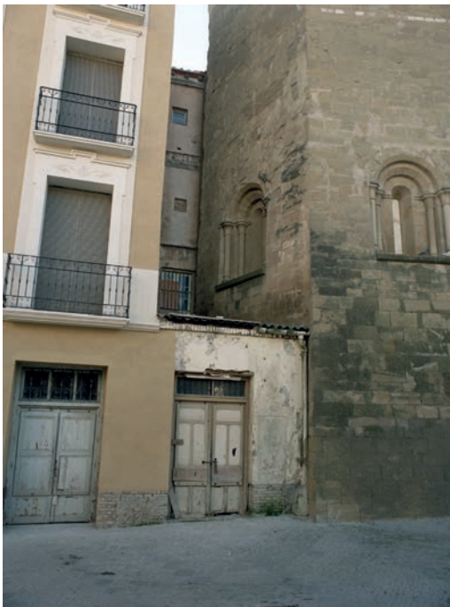
Fig. 5. Torre de la iglesia de San Pedro el Viejo en 1973, con las edificaciones adosadas. (Foto: Fernando Alvira Lizano)
