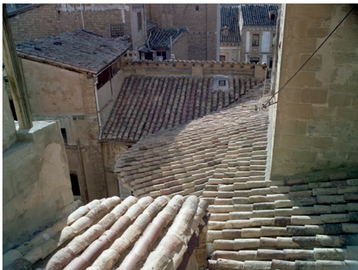
Fig. 7. Situación de los tejados de San Pedro el Viejo antes del proceso de liberación de las edificaciones adosadas. (Foto: Fernando Alvira Lizano)
