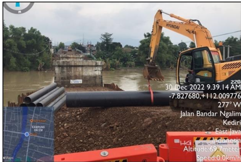
Gambar 1. 2 Lokasi Pembongkaran Proyek Jembatan Bandar Ngalim
