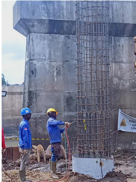
Gambar 4. 12 Proses Pemasangan Tulangan Baja pada P1
