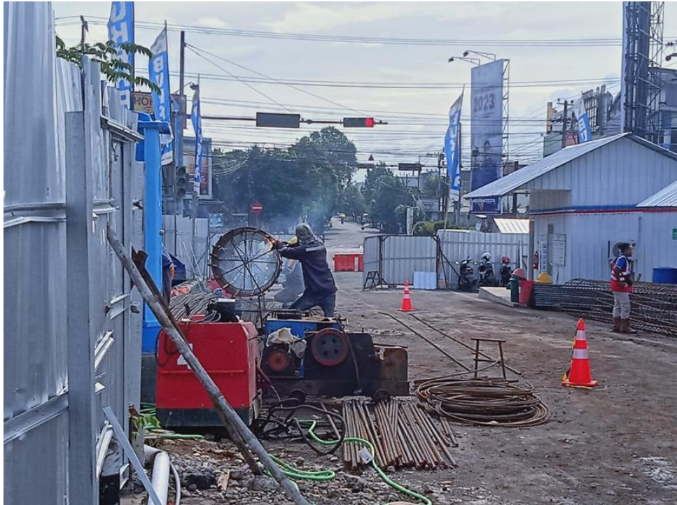
Gambar 4. 6 Pengelasan pada Baja Tulangan
