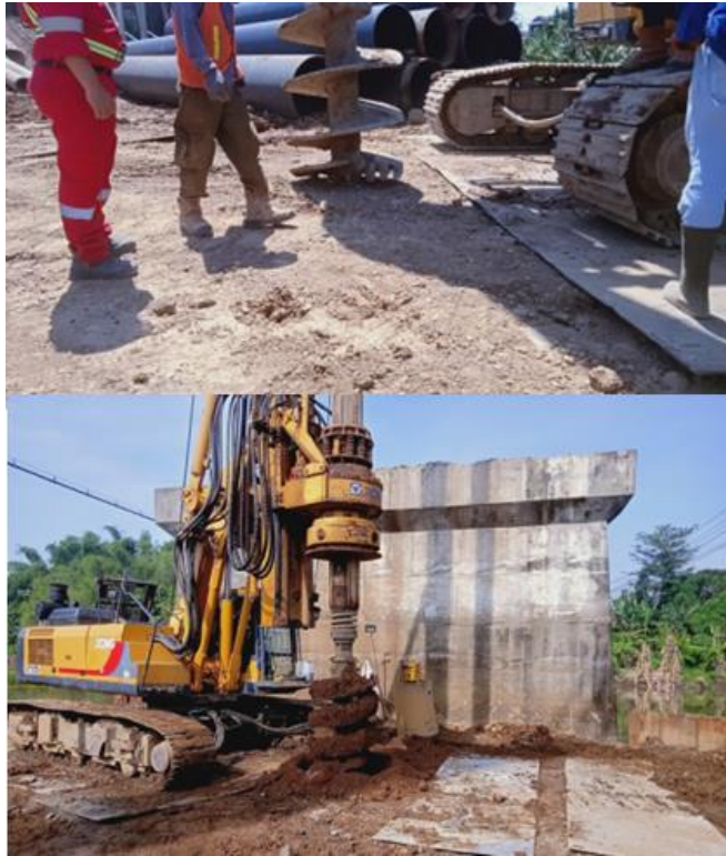
Gambar 4. 8 Proses Pengeboran pada P1
