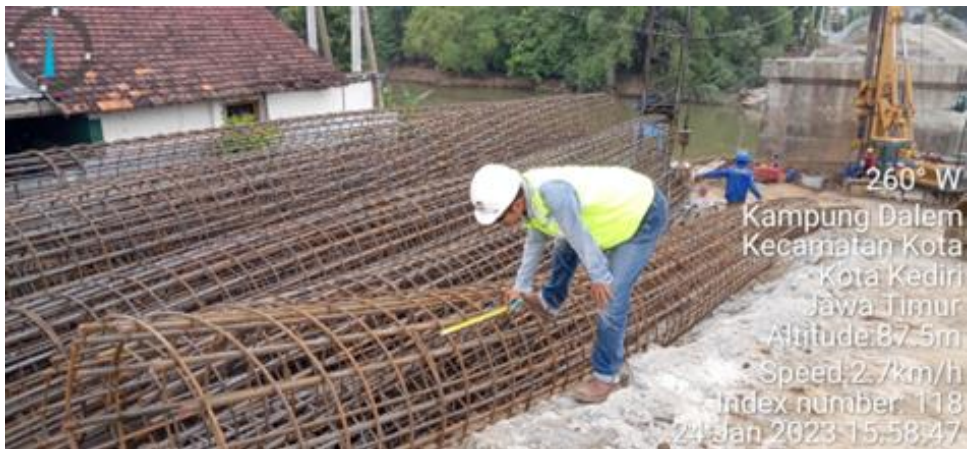
Gambar 4. 7 Pengecekan Baja Tulangan
