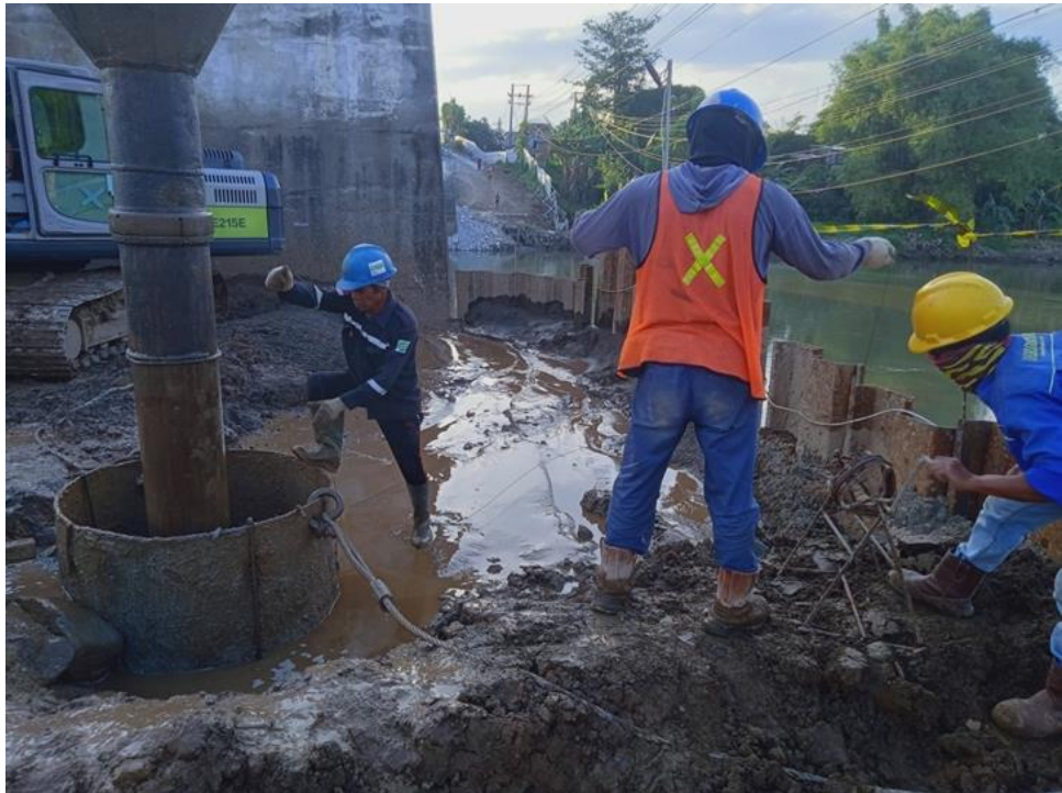
Gambar 4. 21 Proses Pengukuran Kedalaman setelah di Cor pada P1
