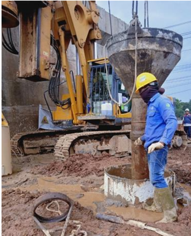
Gambar 4. 14 Proses Pemasangan Corong Tremie pada P1
