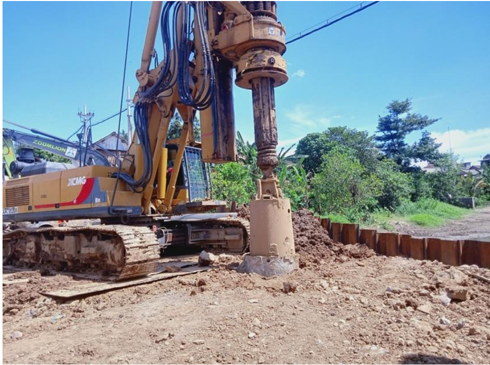
Gambar 4. 10 Proses Drilling pada P1
