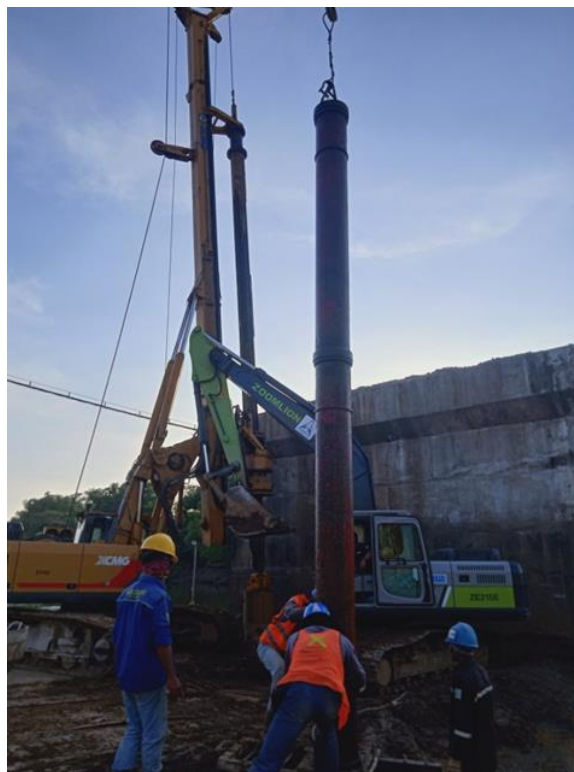
Gambar 4. 13 Proses Pemasangan Pipa Tremie pada P1
