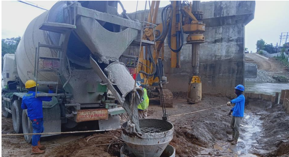
Gambar 4. 20 Proses Pengecoran pada P1
