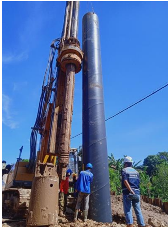
Gambar 4. 9 Proses Pemasangan Casing pada P1
