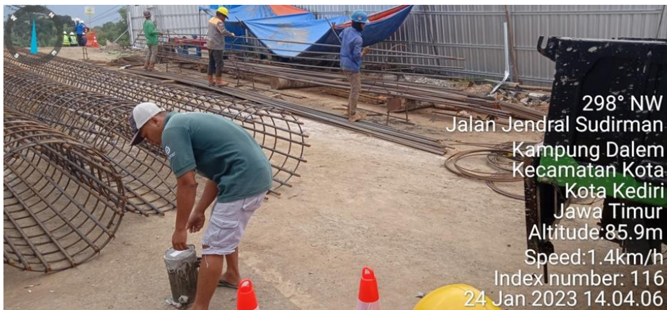
Gambar 4. 5 Perakitan Penulangan Baja
