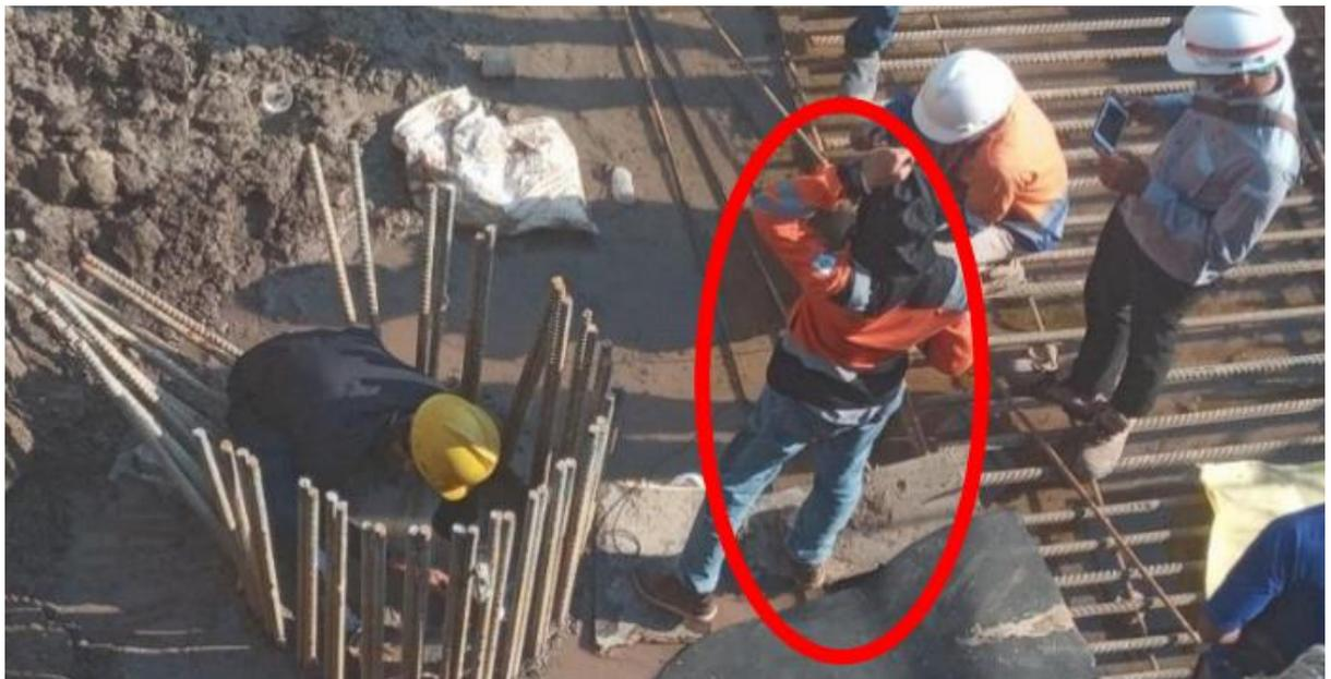
**Gambar 4.21** Pekerja yang tidak menggunakan APD Lengkap
