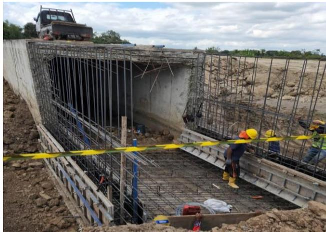
**Gambar 4.22** Perubahan Dimensi pada Pekerjaan *Box Culvert*
