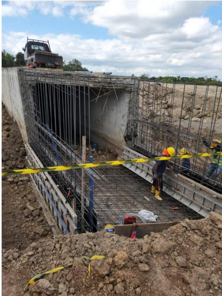
**Gambar 4.1** Pekerjaan *Box Culvert* STA 10+969
