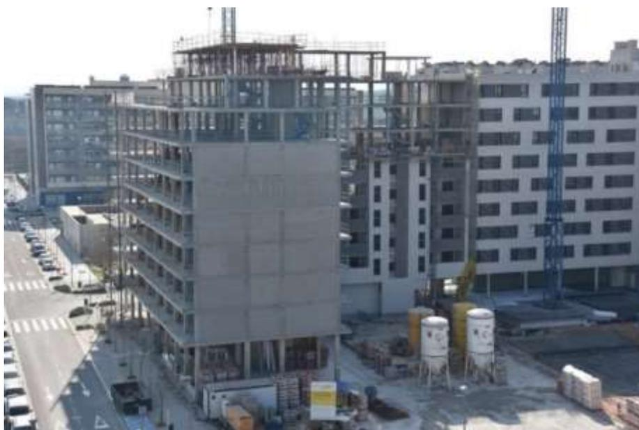
**Ilustración 2.2 Edificio de Gran Canal VII en proceso de construcción. Cerramientos exteriores. Fuente: José Luis Ezquerra**
