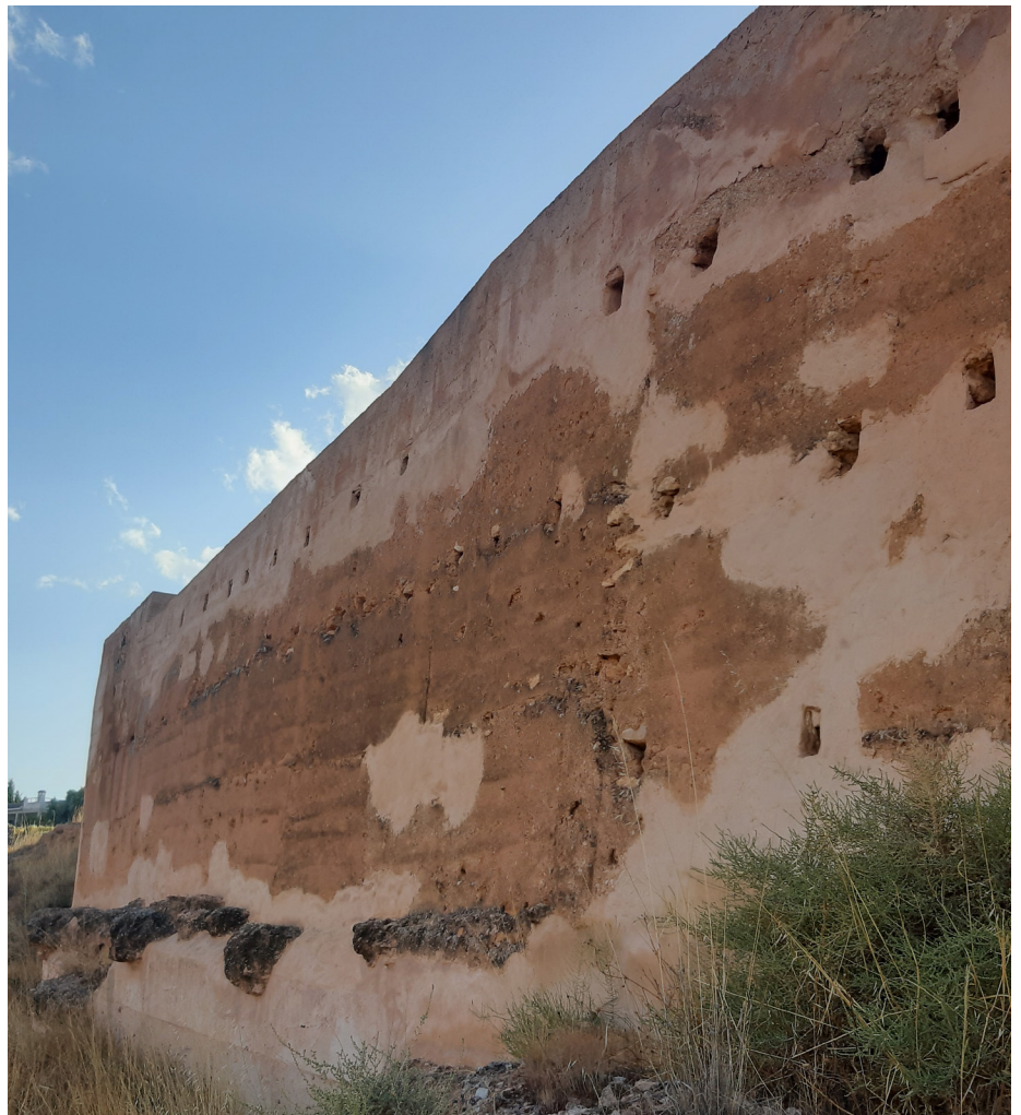
Fig. 37: fachada restaurada de tapial en el castillo de San Jorge, Moyuela.
