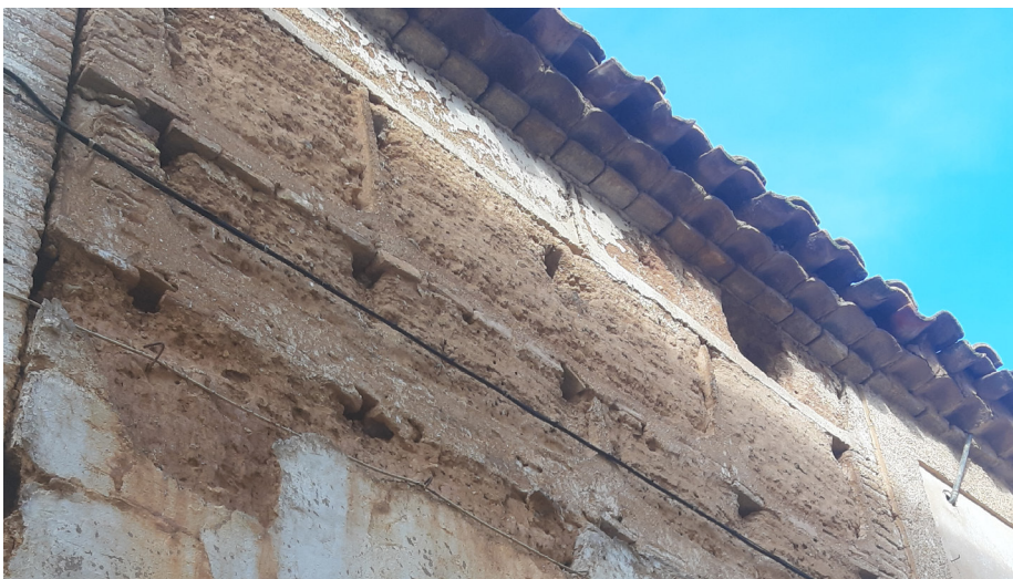
Fig. 38: fachada de tapial en una vivienda en Codo. Verdugadas de ladrillo, aparejo toledano.
