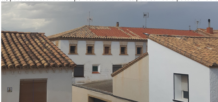
Fig. 47: cubierta retejada en Belchite.
