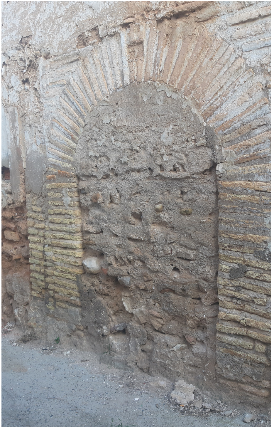
Fig. 57: Antiguo acceso principal de vivienda remarcado con arco en ladrillo.
