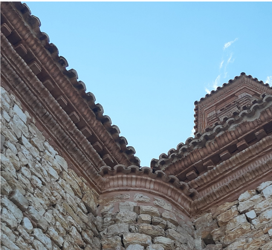
Fig. 40: rafe de ladrillo aplantillado en la cornisa de la iglesia parroquial de Moyuela.
