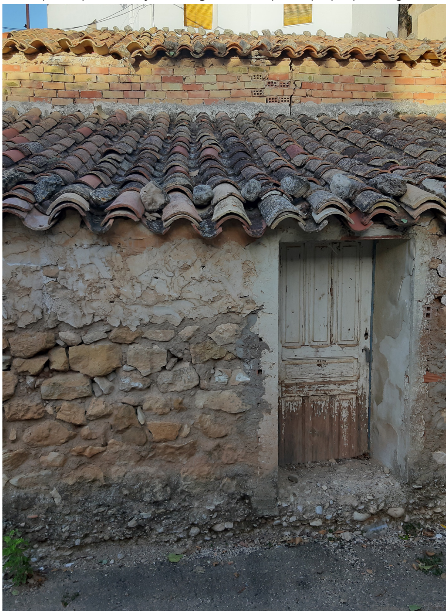
Fig. 60: Corral en Moneva. Muros de piedra y cubierta de teja cerámica curva.
