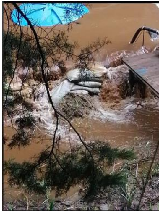
Apéndice KKK. Represa del nacimiento o captación derribada por la fuerza del agua causada por las lluvias constantes.
