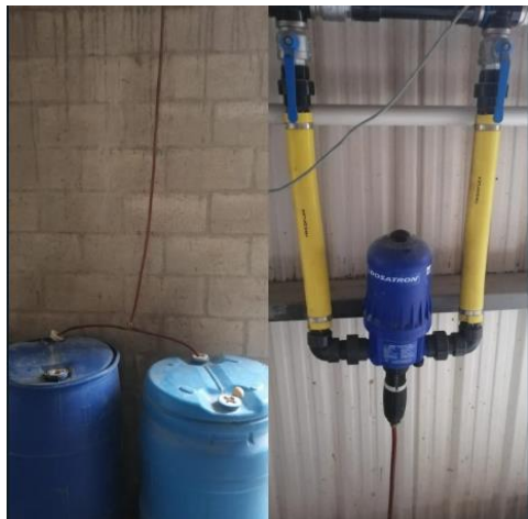
Apéndice CC. Dosatron. La imagen izquierda muestra el bio calcio y acidificante, la imagen derecha muestra el dosatron que los reparte por el galpón.
