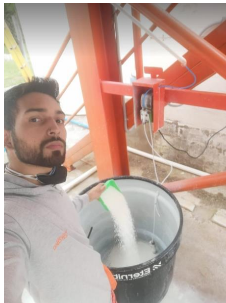
Apéndice ZZ. Aplicación de químicos al agua en la planta de agua.
