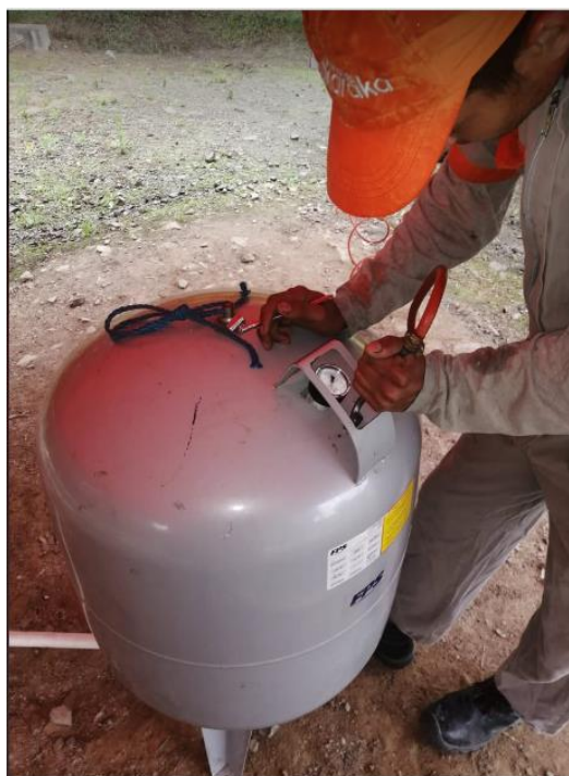
Apéndice JJJ. En la imagen se ve cómo una vez arreglado el HidrFlo se le estaba llenando de aire para darle la presión
