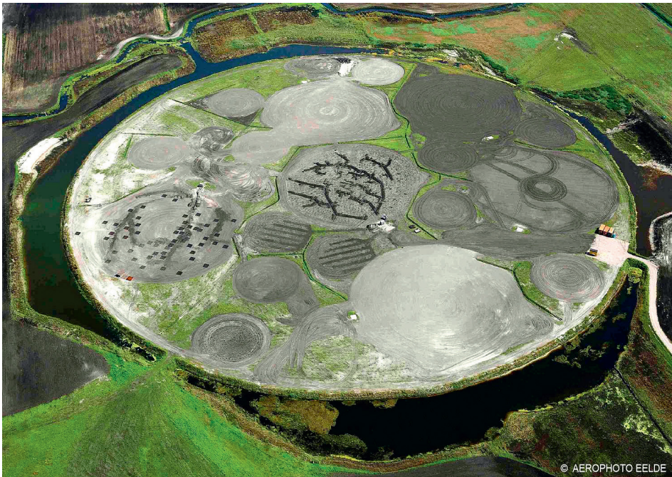
Fig. 9 Het hart van LOFAR waarop 6 core stations zijn gebouwd
