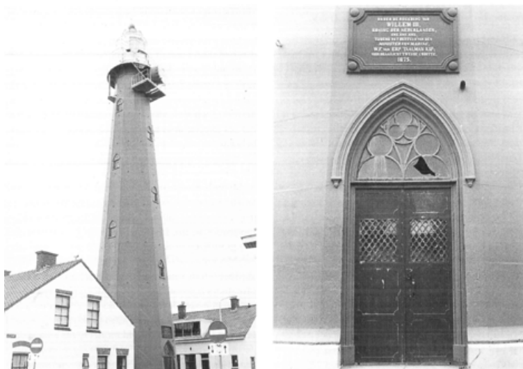
De ijzeren vuurtoren van Scheveningen, in 1875 in gebruik genomen voor een 'draailicht [van de] tweede grootte'. Ook dit is een produkt van de ijzergieterij Nering Bögel & Co uit Deventer.
