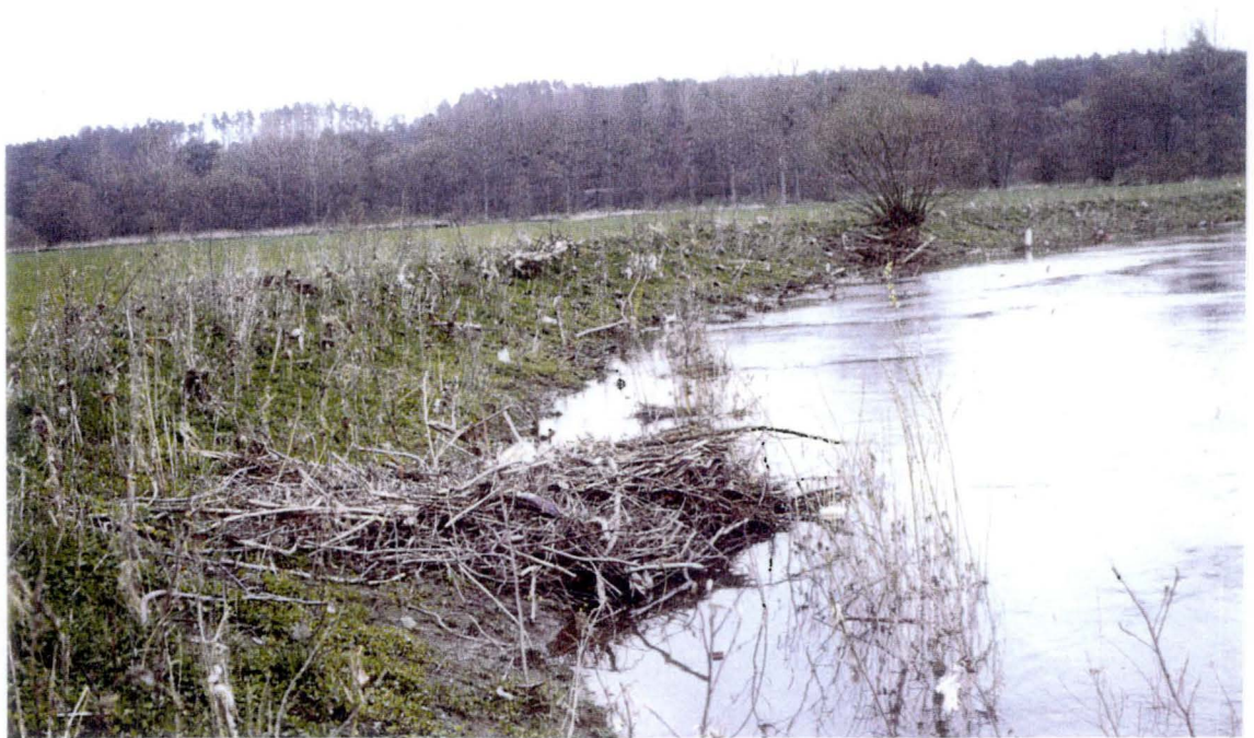
Figure 38 : Photo représentant les branches accumulées au niveau du troisième sous-secteur lors des crues.
