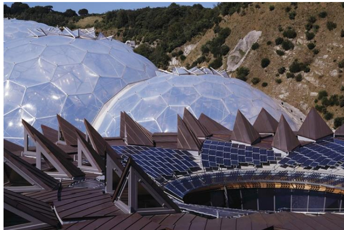
Gambar 4. Instalasi Panel Photovoltaic pada Core the Eden Project
