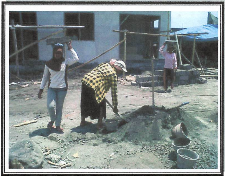
FOTO 5 : TENAGA KARJA WANITA PADA PROYEK PERUMAHAN DI PROPISI BALI
