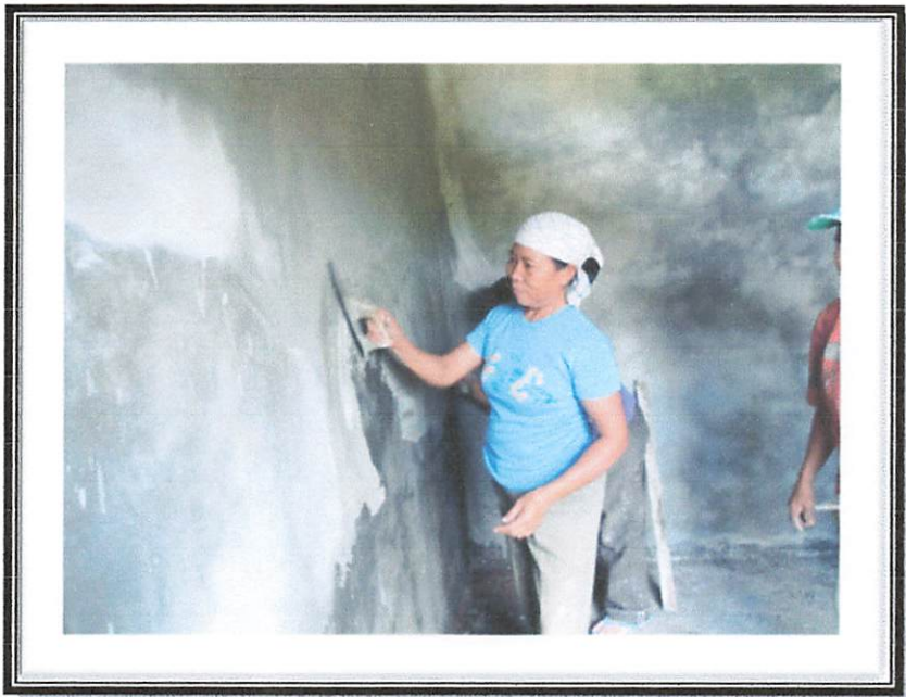
FOTO 2 ;TENAGA KERJA WANITA PADA PEKERJAAN ACIAN
