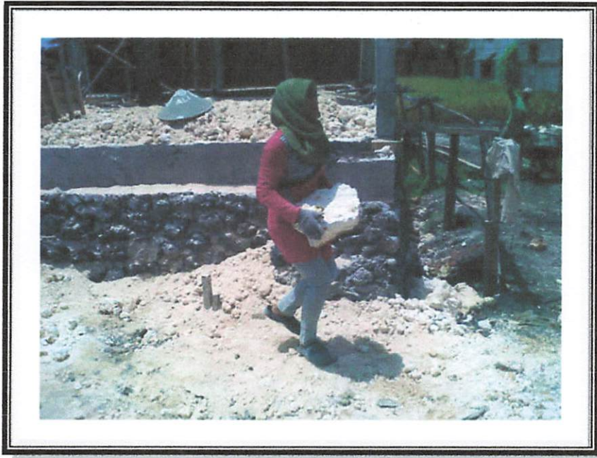
FOTO 1 : PEKERJA PASANGAN BATU
