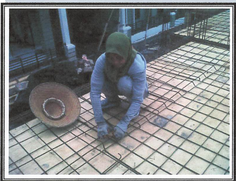
FOTO 6 : TENAGA KARJA WANITA PADA PEKERJAAN PEMBESIAN
