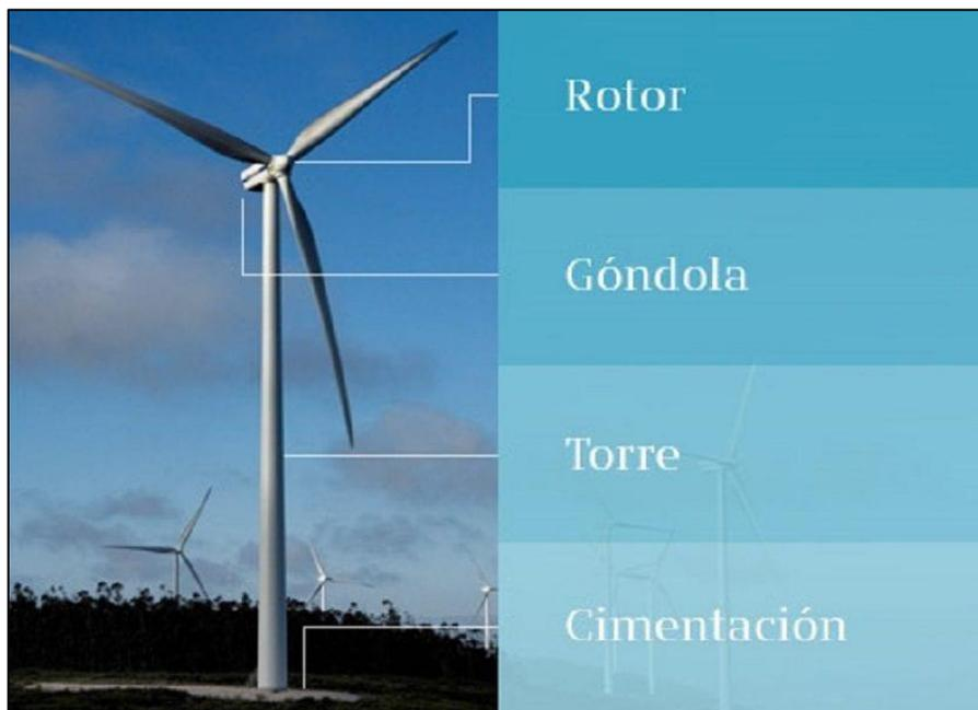
**Figura 3. Aerogenerador y sus partes.**
