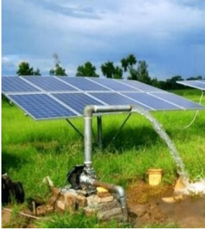
Gambar 13.11. Pompa air tenaga surya untuk irigasi sawah Sumber: https://climatebiz.com/solar-water-pumping/
