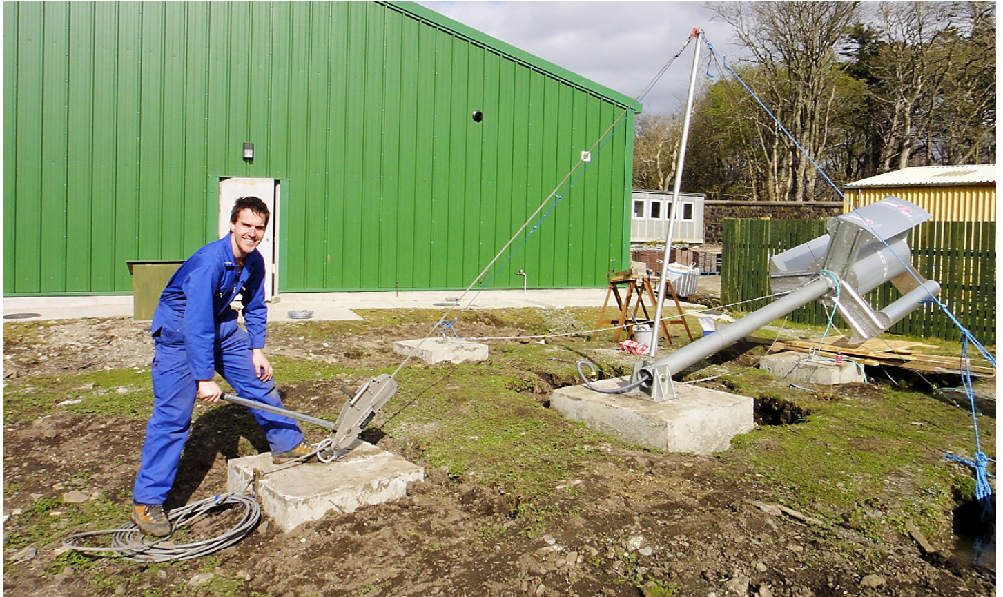
Erstes Aufrichten der Vertikalachs Windturbine (VAWT) durch Ruedi Schmid auf dem Versuchsgelände für Erneuerbare Energien auf dem Campus des Lews Castle College in Stornoway. Das Projekt wurde durch FES Facilities Management gesponsert. http://news.nationalgeographic.co.uk/news/energy/2012/08/120820-helix-wind-collapse/ (Bild: Ruedi Schmid)
