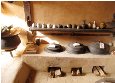
Korean Folk Village: tiefer gelegene Feuerstelle im traditionellen Haus. Sie dient zugleich zum Kochen und als Wärmequelle für die Fussbodenheizung.
