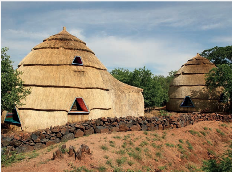
Der fertig gestellte Kindergarten.
