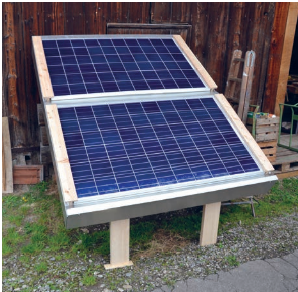
Prototyp einer Holzunterkonstruktion für ein Aufdach-System.
