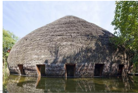
أ: المبنى ضمن الطبيعة المحيطة وتكامله معها
