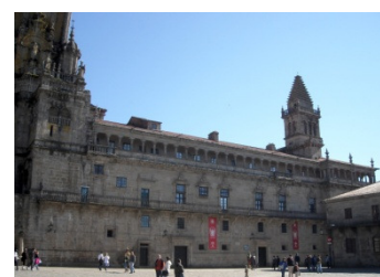
Figura 47 fachada do claustro da Catedral.
