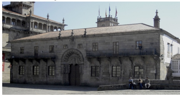
Figura 38 fachada meridional da Praça do Obradoiro: Colégio de San Xerome.
