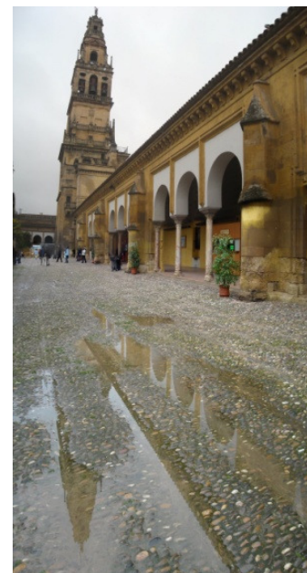
Figura 129 campanário, visto desde o pátio.
