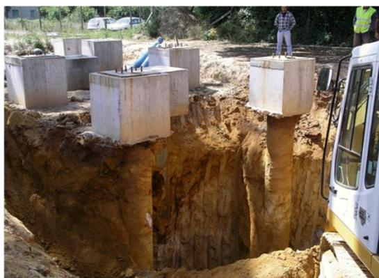
Fig. 7.27 Extracção de Estacas Moldadas e Cravadas em Solo Residual – CEFEUP
