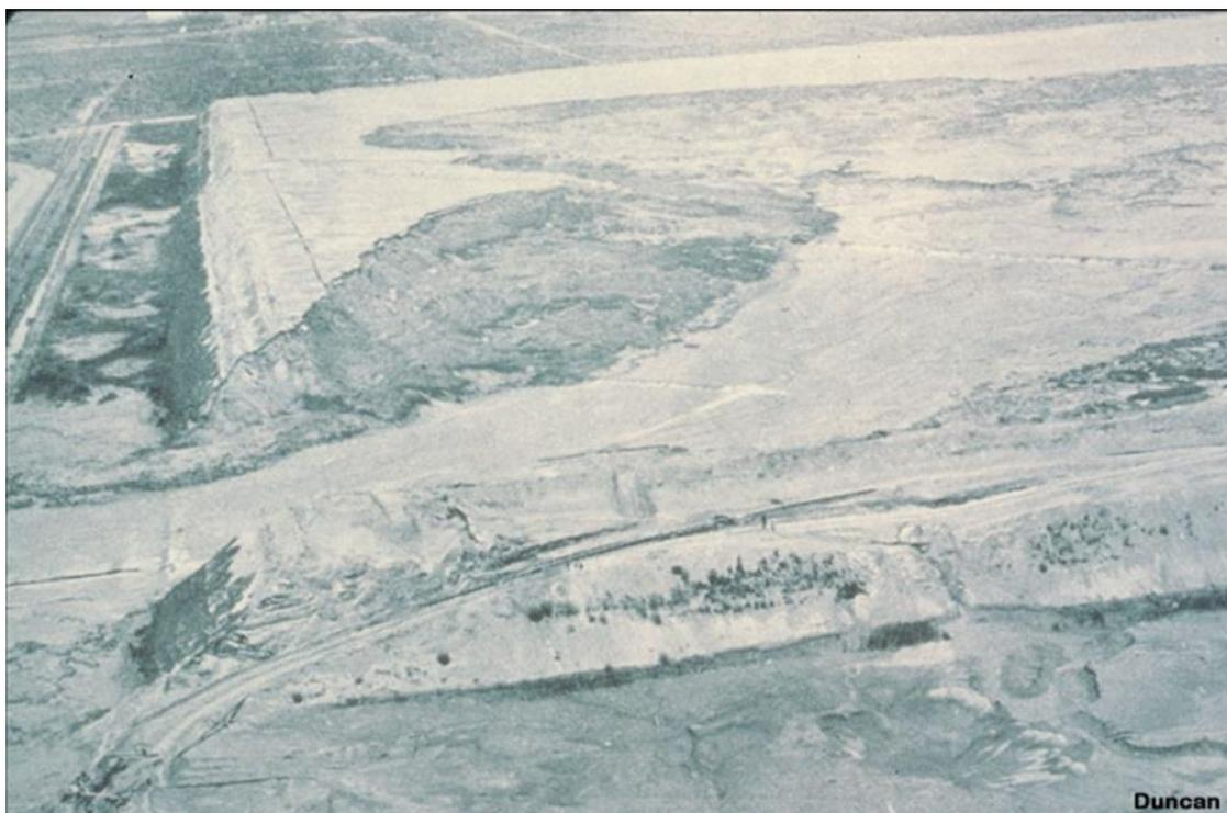
Ruptura de barragens de resíduo de cobre (material silto arenoso, ÑP)(Cerro Negro, Chile, 2003)
