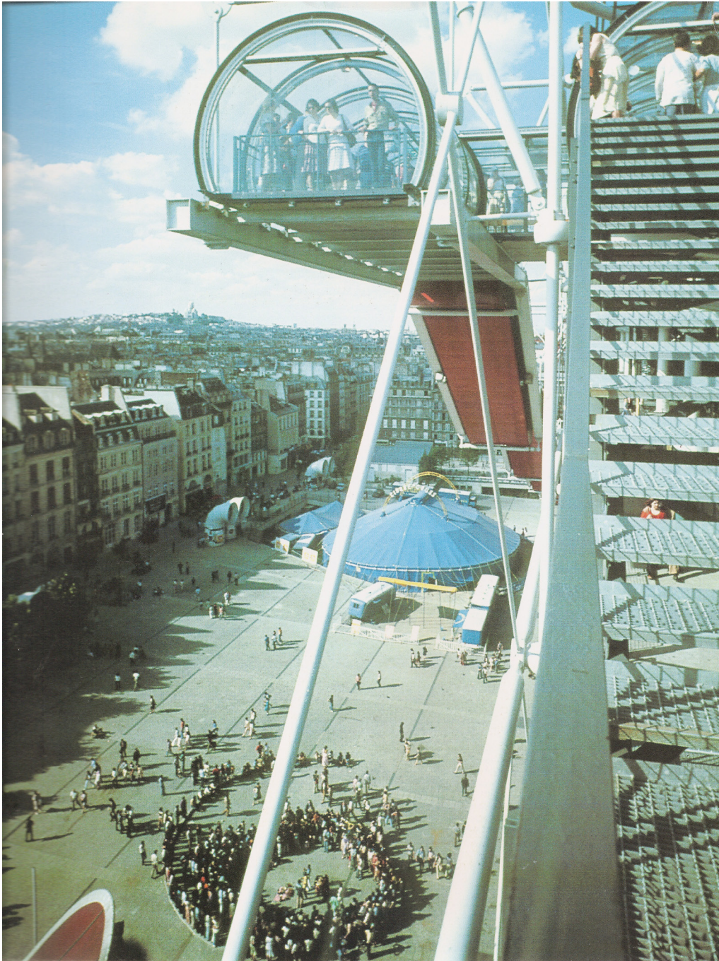
Fig. 15 O edifício e a urbe Vista desde as escadas de distribuição do museu sobre a cidade e a praça;
