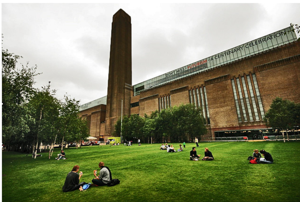
Fig. 5 a) e b) A abertura da antiga estação eléctrica reconvertida num museu de arte moderna, apesar da limpeza da caixilharia das janelas, da adição de dois pisos sobre a cobertura e da retirada do pequeno volume na base da chaminé. As transformações tornam o edifício mais “limpo” e as suas linhas tornam-se mais fortes.
