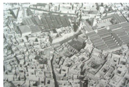
vista aérea da cidade de Fez, em Marrocos, onde se pode distinguir a mesquita perfeitamente integrada no conjunto urbano
