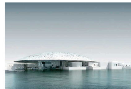
e Louvre Abu-Dhabi, do atelier de Jean Nouvel, render onde é possível ver o aspecto da gigantesca cobertura rendilhada que proporciona espaços de sombra exteriores
