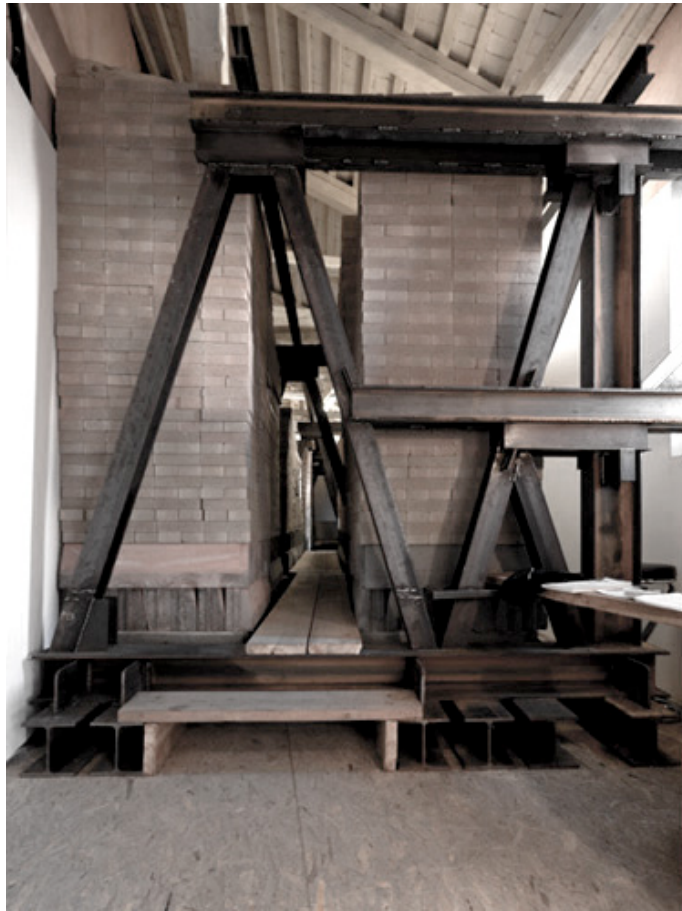
Fig.25 Pavilhão de Portugal, Bienal de Veneza, sistema construtivo da fachada
