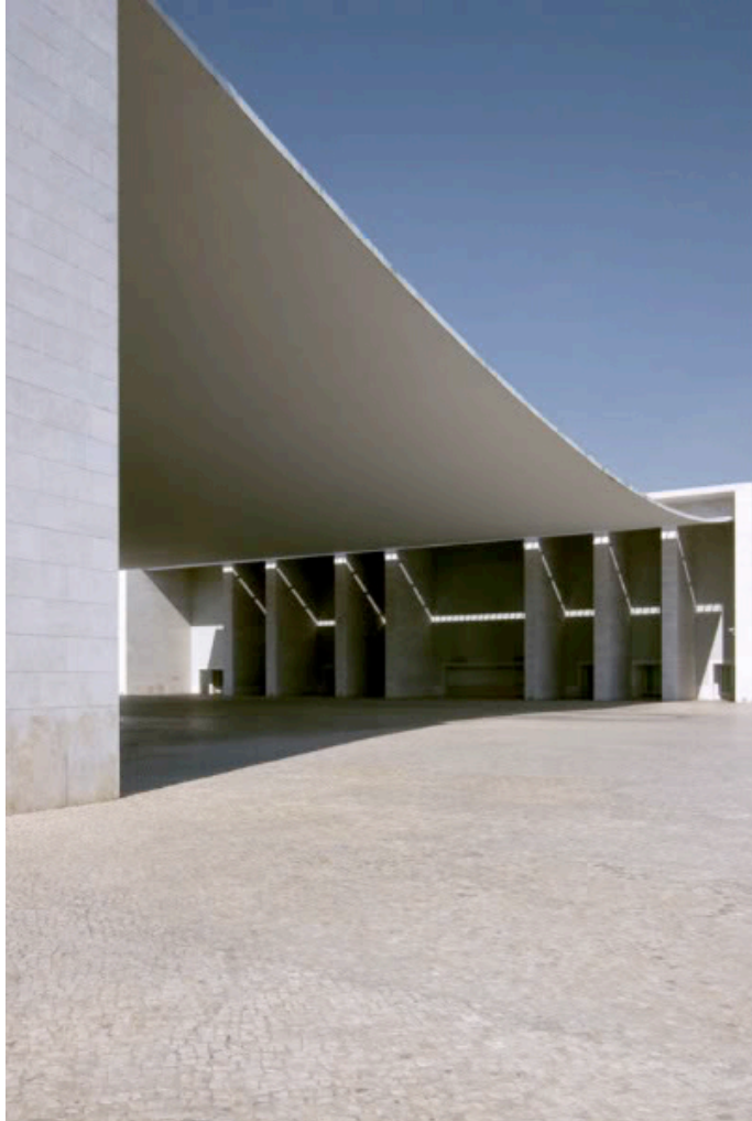
Fig.13 Pavilhão de Portugal; a pala
