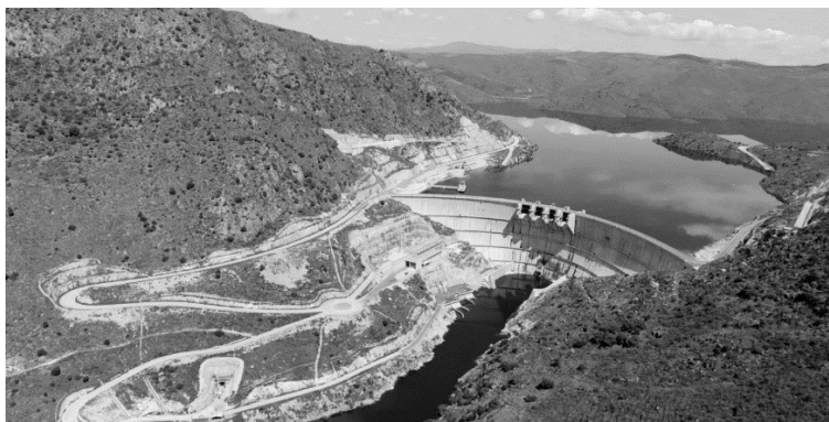
Figura 2. Vista aérea da Barragem do Baixo Sabor, adaptado de [14].
