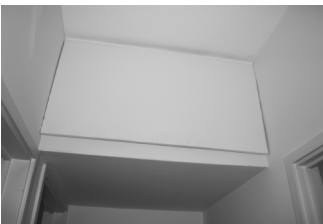
88 a 91 | Interior de um fogo T3, sala, entrada, zona de quartos, pormenor de armário superior com pé direito mais baixo
