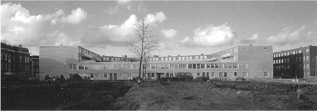
Fig. 119. Vista da fachada noroeste do bloco Punt, Schilderswijk.
