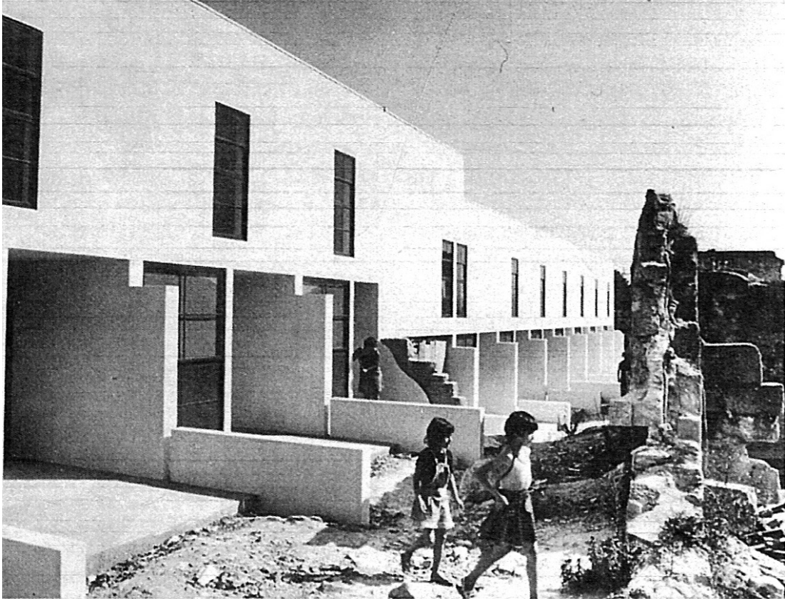
Fig. 20. Vistas do bloco e da ruína em S. Vitor, Porto.
