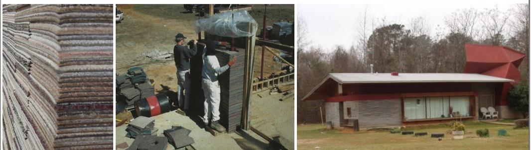
[fig.1] Alcatifas sobrepostas [fig.2] Montagem da parede de alcatifa [fig.3] Lucy's Carpet Tile House, Mason's Bend, Alabama, Rural Studio, 2002
