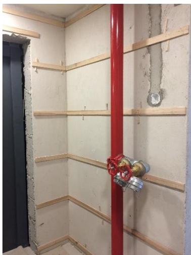
Fig.4.35 - Coluna seca e bocas de incêndio
