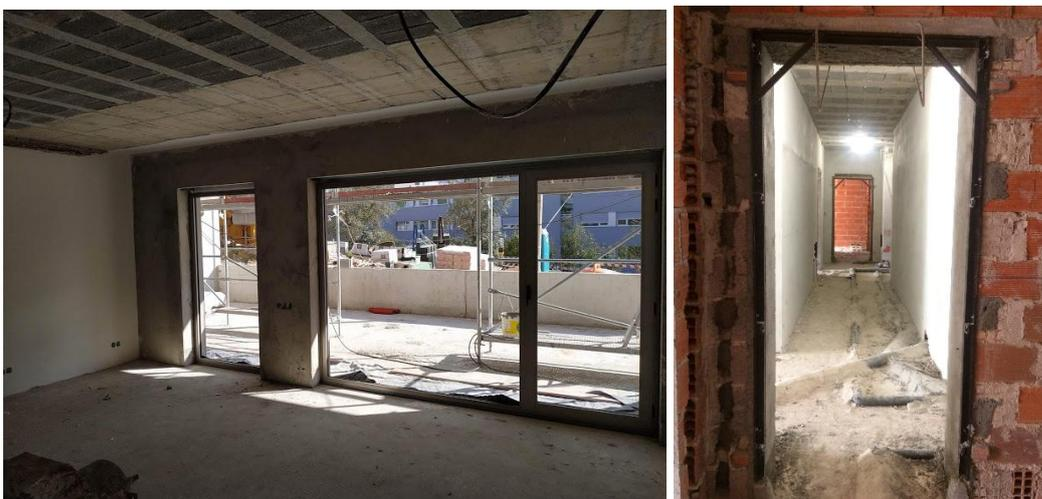
Fig.4.28 - Caixilharia em alumínio; Estrutura para portas
