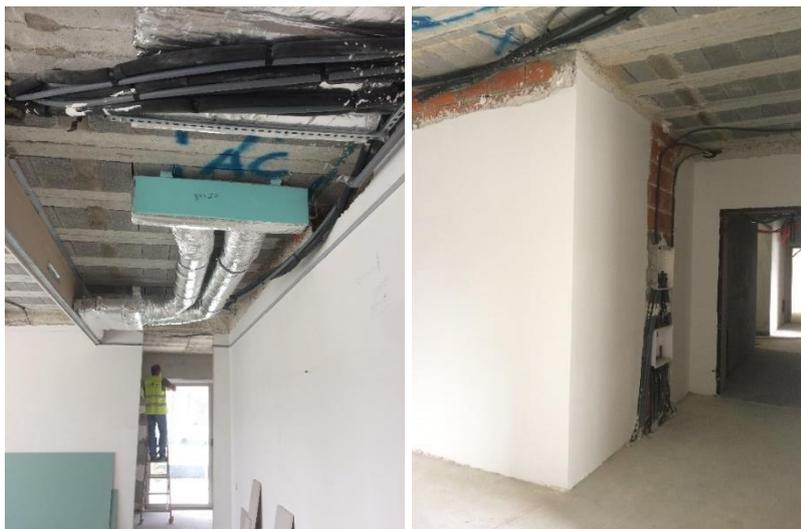
Fig.5.4 - Colocação de tetos falsos Bloco 3 (Tirada a 28/02/2020)
