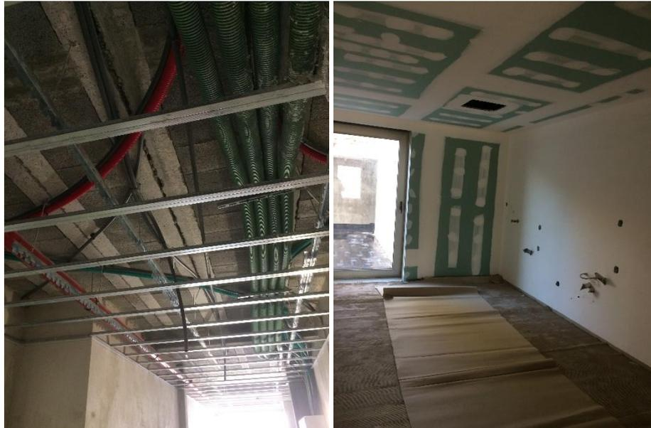
Fig.4.26 - Estrutura metálica nos tetos; Gesso cartonado hidrófugo
