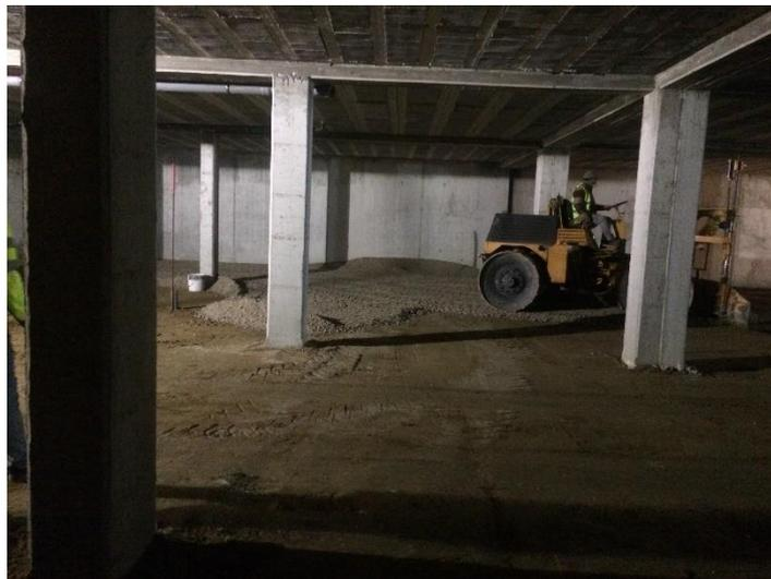
Fig.5.7 - Colocação da camada de base no pavimento térreo (Tirada a 28/02/2020)
