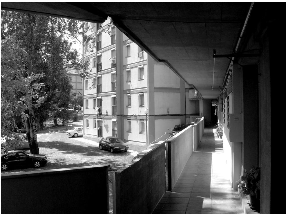
53\_ Unidade dos Olivais, actualmente. Vista de uma das galerias a partir da caixa de escadas. Nota-se nas guardas os elementos pré-fabricados usados pelo arquitecto para corresponder às exigências orçamentais.
