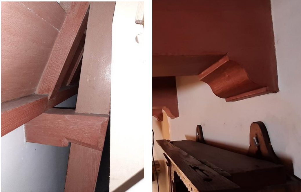
Linker achtervleugel: kreupele stijl in kap en console op eerste verdieping (foto's auteur).
