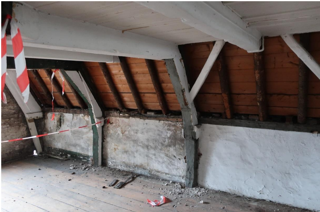
Zolder, overzicht kapconstructie (foto Jos Smit, Monumenten en Archeologie).
