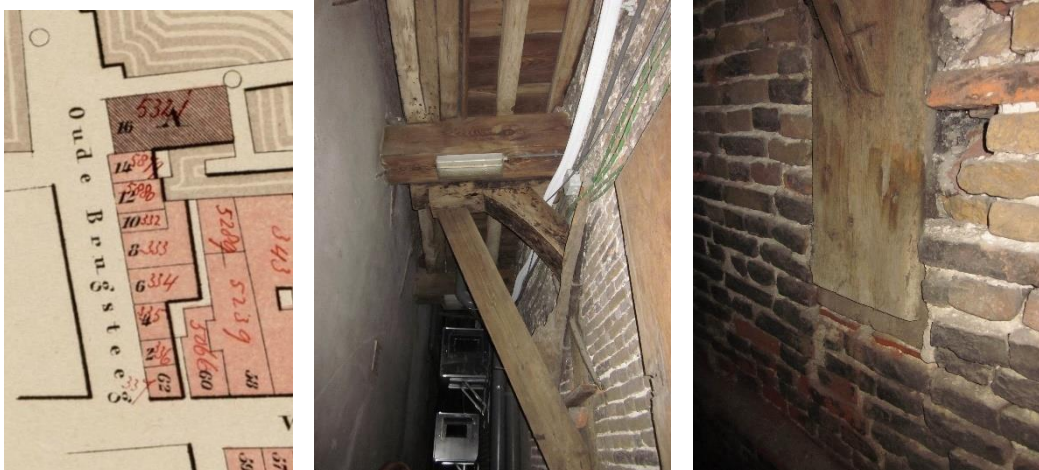
De steeg achter de bebouwing aan de Oudebrugsteeg, met zestiende-eeuwse overkraging uitgevoerd met korbeels en op zandstenen neuten rustende muurstijlen (Stadsarchief Amsterdam, 01004300002 en foto's auteur).
