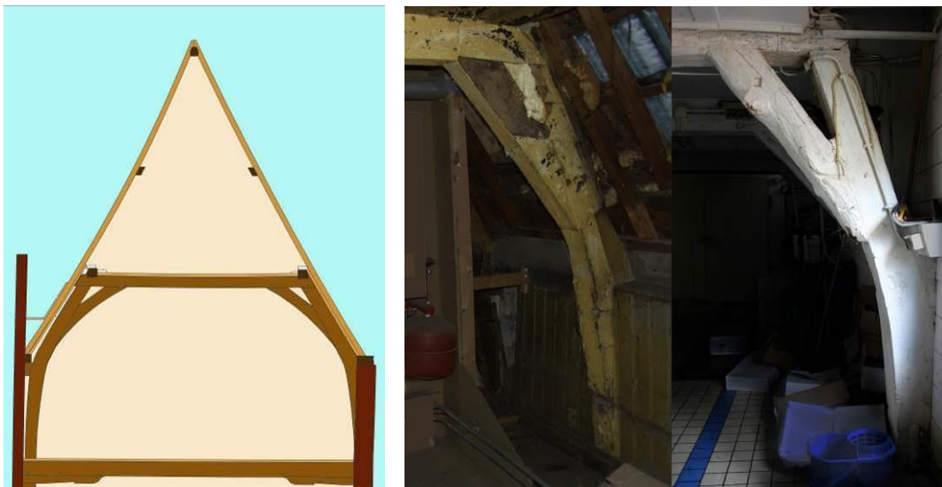
Doorsnede van de kapconstructie van Sint-Jansstraat 39 (gesloopt 2002, vermoedelijk circa 1600, tekening door Dik de Roon) en krommers in de kappen van Spaarpotsteeg 2 (ongedateerd) en Spui 3 (1559-'61d), (Monumenten en Archeologie).
