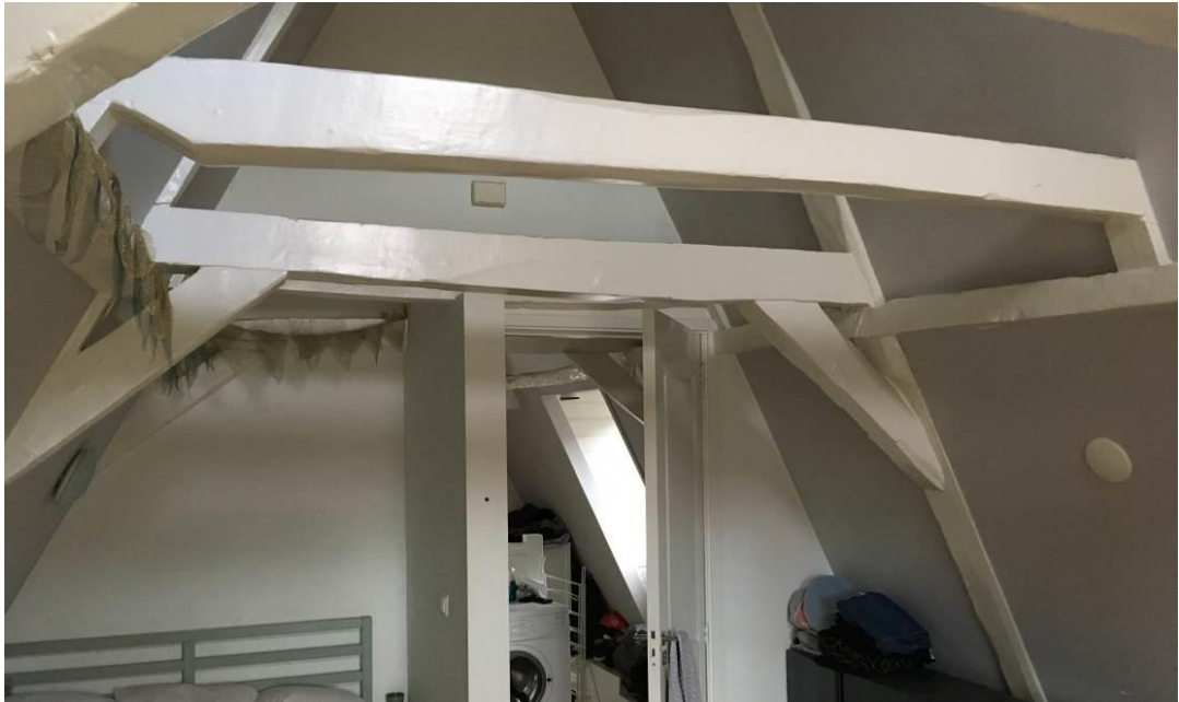
Lange Niezel 10, gestapeld spant aan de voorzijde (foto auteur).
