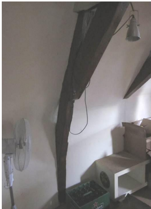
Oude Doelenstraat 20: exterieur en rechtop gezaagde eiken krommer in de kap (foto's auteur).
