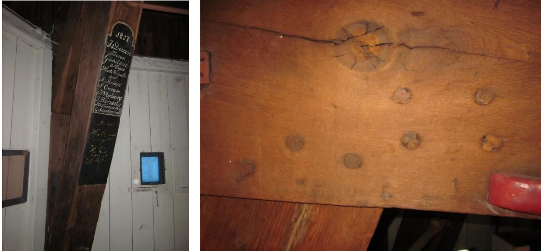
Zandstraat 17, Zuiderkerkstoren: verstevigende schoor in de beiaardierskamer en houtvlotverbindingen op balk (foto's Dik de Roon en Gabri van Tussenbroek).
