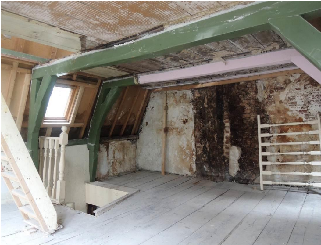
Spuistraat 61, zolder met kapconstructie (foto auteur).
