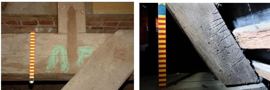
Bad Segeberg, merktekens in het dak van de Stiftskirche uit 1864, naar ontwerp van Hermann Georg Krüger en Breitenfelde, merktekens in de kapconstructie van de kerk uit 1878, naar ontwerp van C.A.W. Lohmeyer (foto's Bernd Adam).
