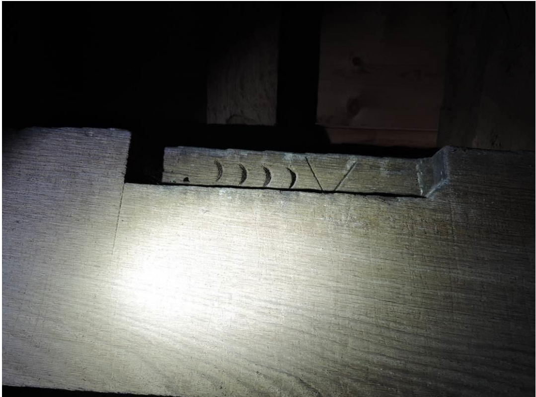
Westerkerk, hoofdkap: telmerk in de aansluiting van een verbinding (foto David Derksen/ Monumenten en Archeologie).
