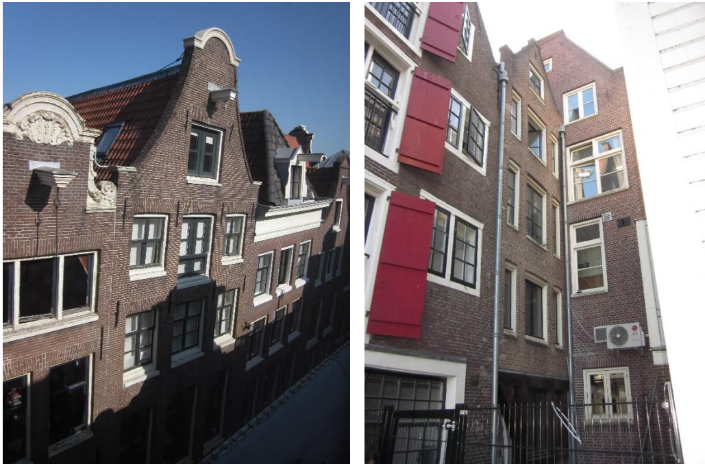
Oudebrugsteeg 8, voorgevel en gevel van het dwarshuis gezien vanaf het Damrak (foto's auteur).
