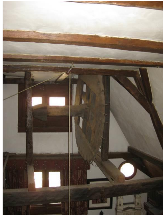
Geldersekade 8, voorgevel en overzicht kapconstructie achterzijde met hijssrad (foto's auteur).
