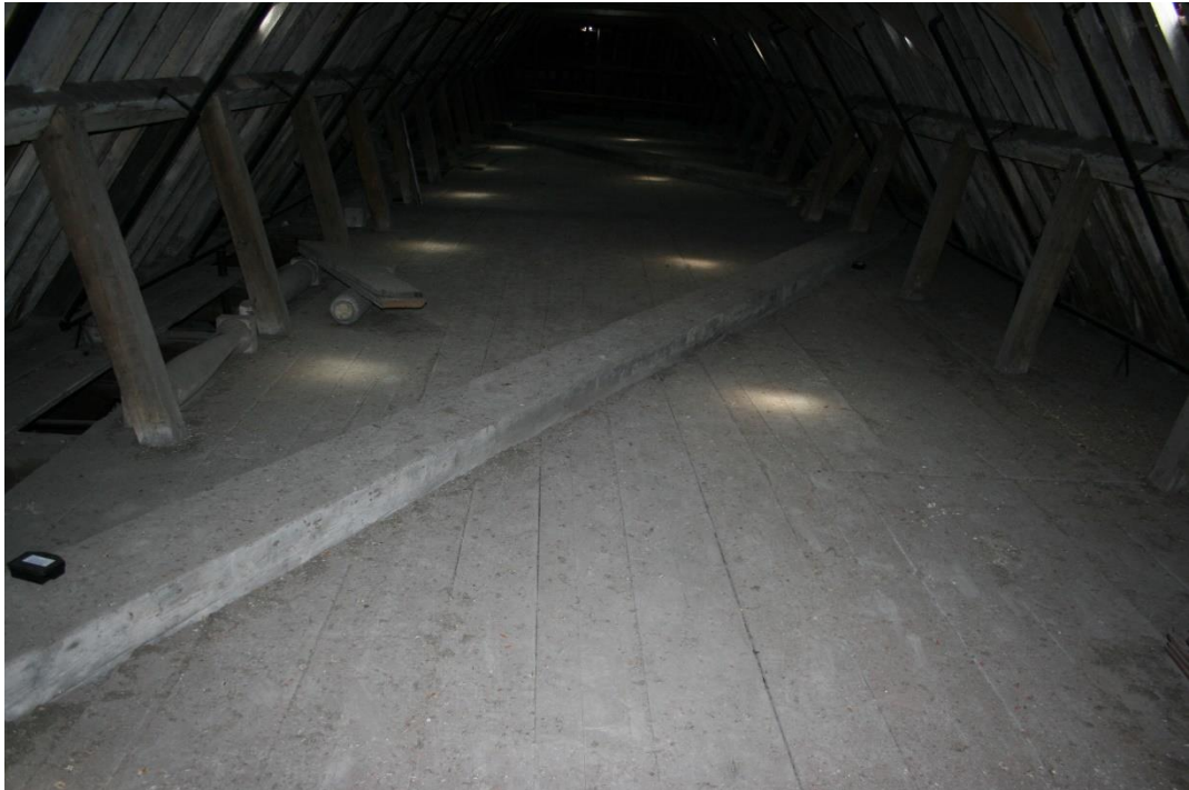
Meester Visserplein 3, horizontale schoor op zolderniveau (foto Dik de Roon 2007).
