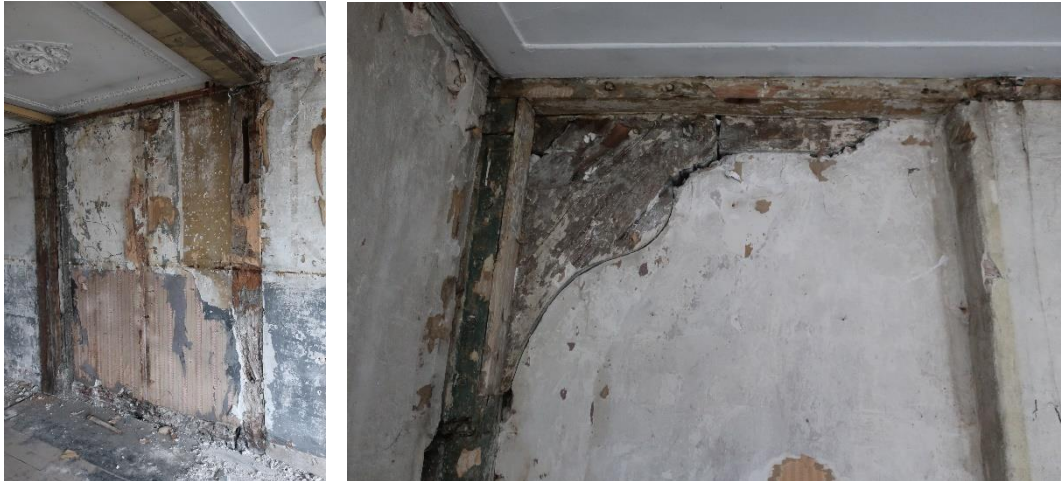
Oudezijds Voorburgwal 61: muurstijlen en korbeelstel (foto Jos Smit, Monumenten en Archeologie).
