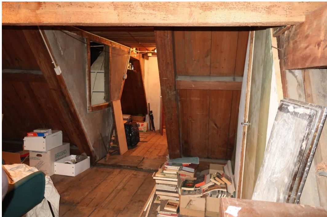
Nieuwezijds Voorburgwal 282, impressie van de vliering met dwarskappen en middenstraat (foto Jos Smit/ Monumenten en Archeologie).
