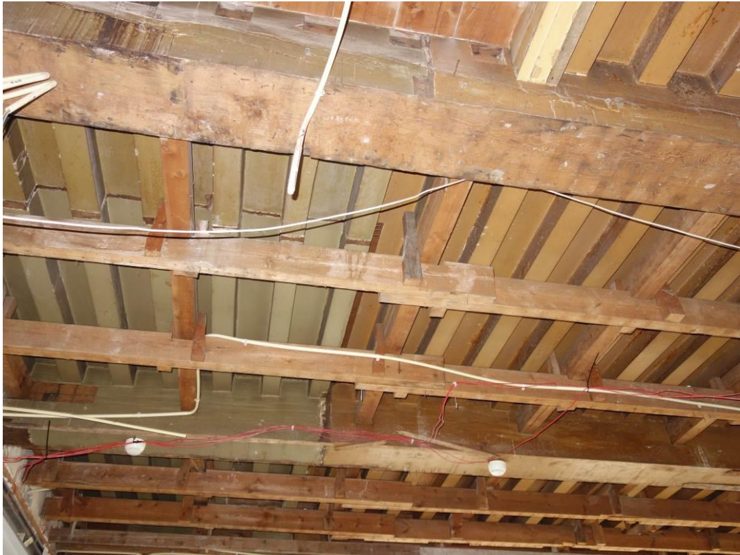
Oude Turfmarkt 147, samengestelde balklaag tweede verdieping voorhuis, achterzijde (foto auteur).
