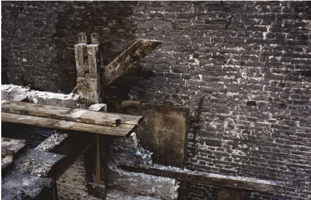
Warmoesstraat 96 tijdens de sloop in oktober 1959 met een deel van het houten beschot (Monumenten en Archeologie).
