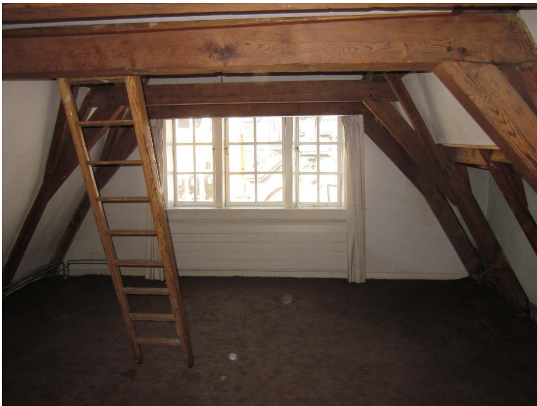
Singel 28, achterhuis: kapconstructie (foto auteur).
