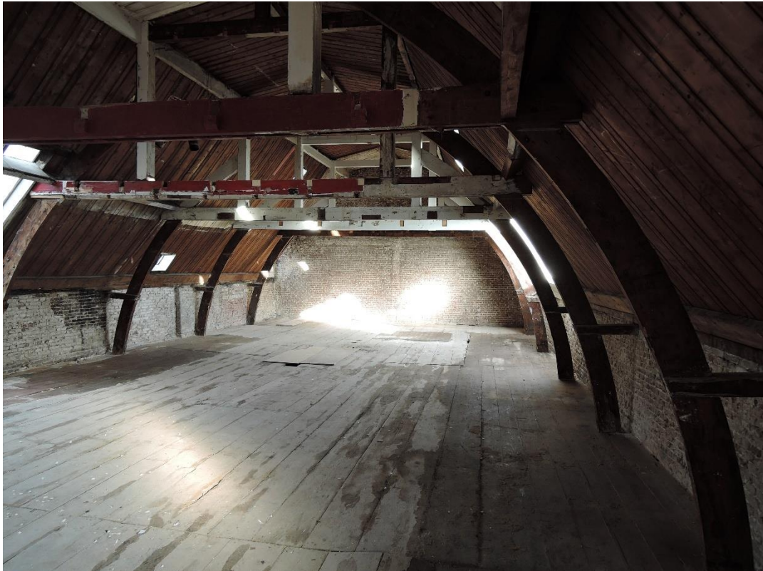
Spuistraat 199, opname kapconstructie uit 1875 (foto auteur).
