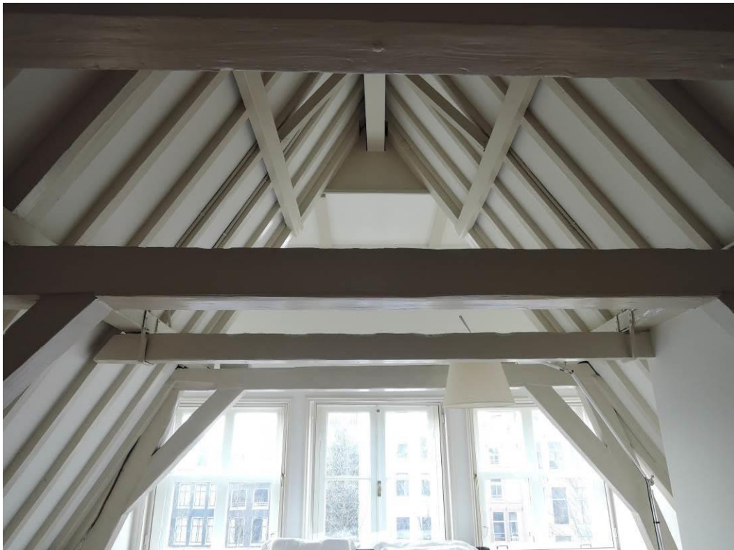
Een blik in de kapconstructie (foto Monumenten en Archeologie).
