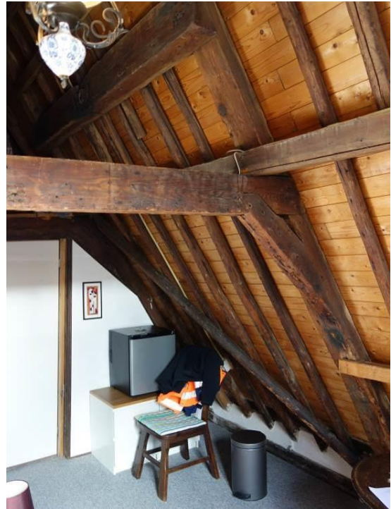
Oudebrugsteeg 6, alternerende houtskelet en overzicht kapconstructie (Monumenten en Archeologie).
