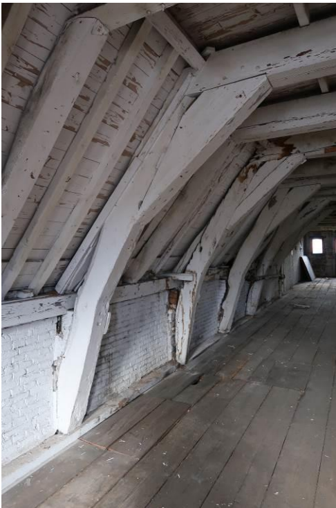
Brouwersgracht 167, zolder. Krommers aan rechterzijde en aftekening oude daklijn tegen voorgevel (foto's David Derksen/ Monumenten en Archeologie).
