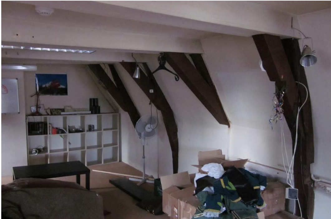
Oude Doelenstraat 20: overzicht van de kapconstructie (foto auteur).
