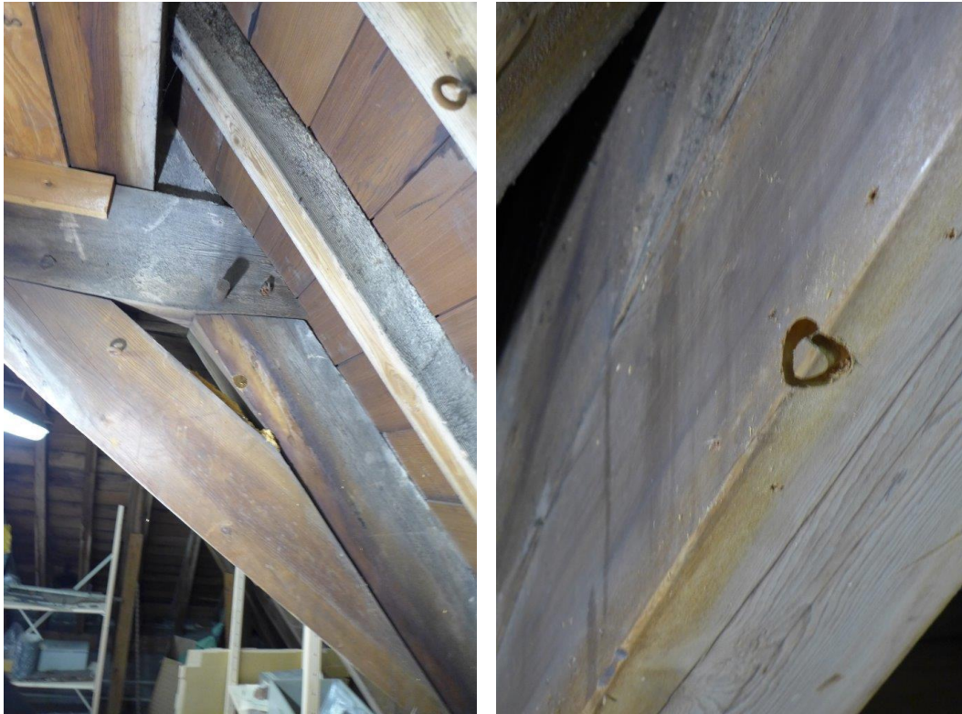
Herengracht 605, deel van een dekbalkspant en impressie van het scherp gezaagde hout (na monstername) (foto's Jaap Boonstra, Amsterdam Museum).
