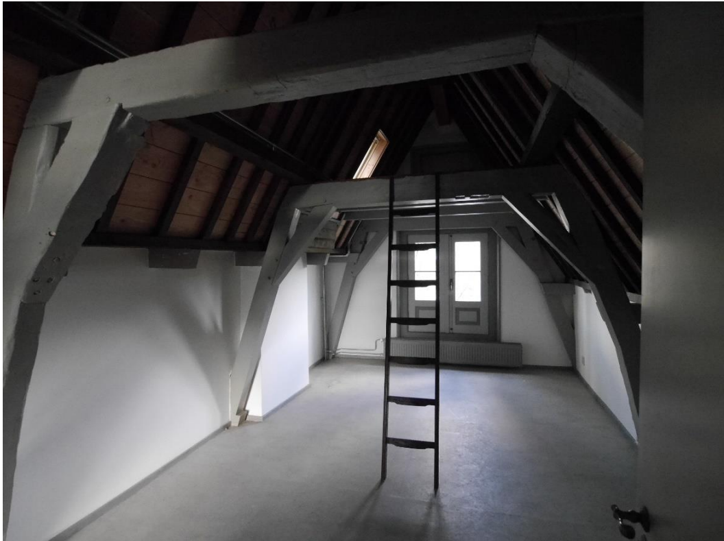
Oude Waal 7: kapconstructie (foto Vereniging Hendrick de Keyser).
