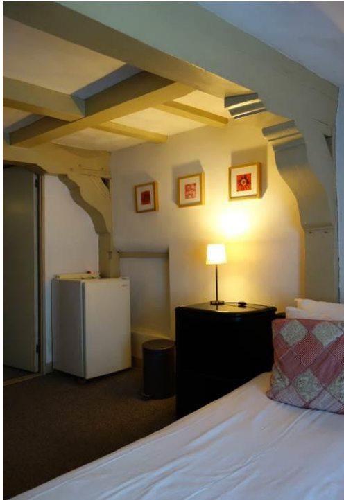
Oudebrugsteeg 6, alternerende houtskelet en overzicht kapconstructie (Monumenten en Archeologie).
