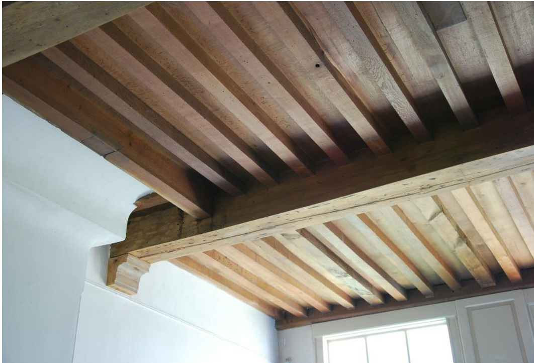
Singel 28, achterhuis: samengestelde balklaag op de bel-etage (foto auteur).
