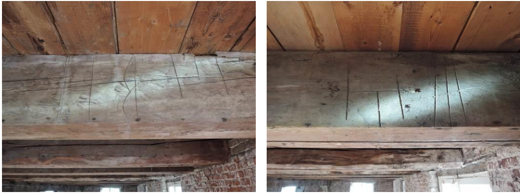
Spuistraat 199, twee voorbeelden van op de derde verdieping aangetroffen houthandelsmerken (foto's David Derksen/ Monumenten en Archeologie).
