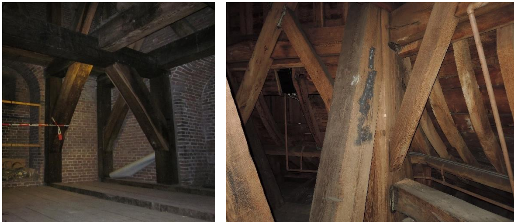
Zandstraat 17, Zuiderkerkstoren: houtconstructie in vierkante onderbouw en schoorconstructie in spits (foto's Dik de Roon/ Monumenten en Archeologie).
