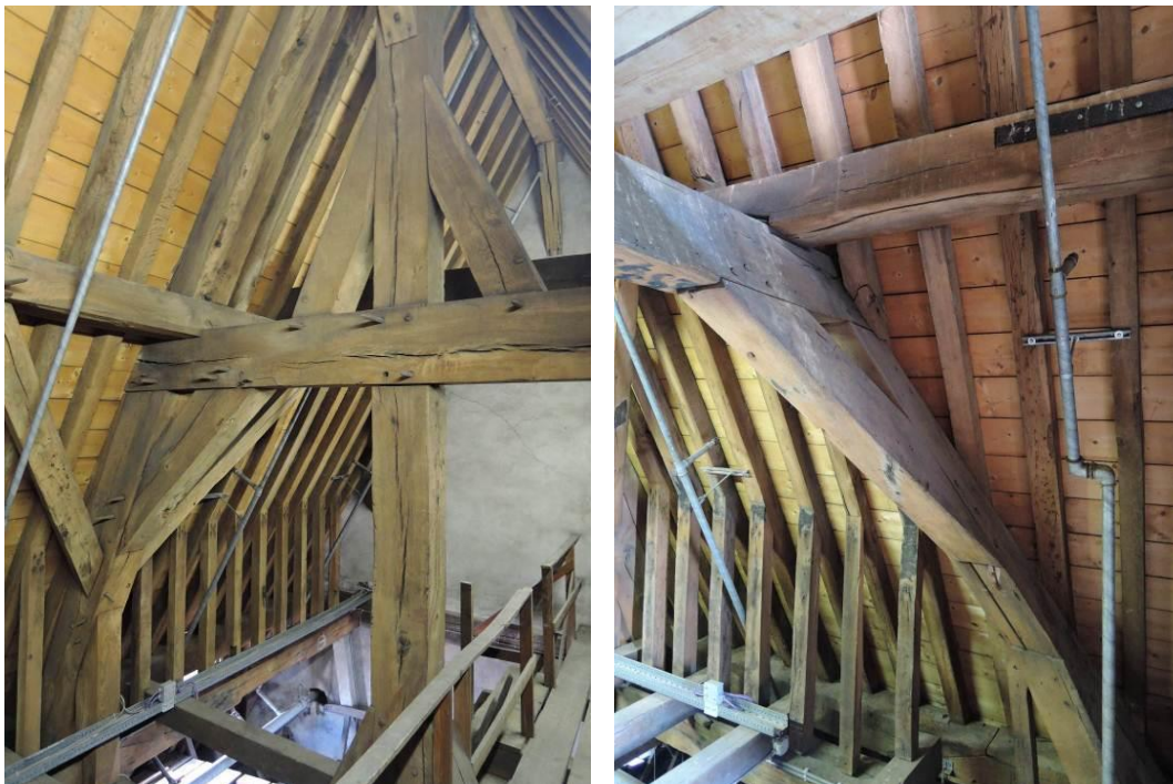
Westerkerk, hoofdkap (foto's auteur).
