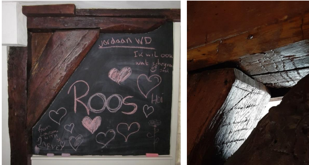
Oudebrugsteeg 8, korbeelstel tegen de achtergevel en gekrast telmerk IIII (foto's auteur).
