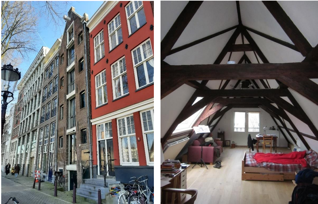
Oudeschans 13: voorgevel en overzicht kapconstructie (foto's auteur).
