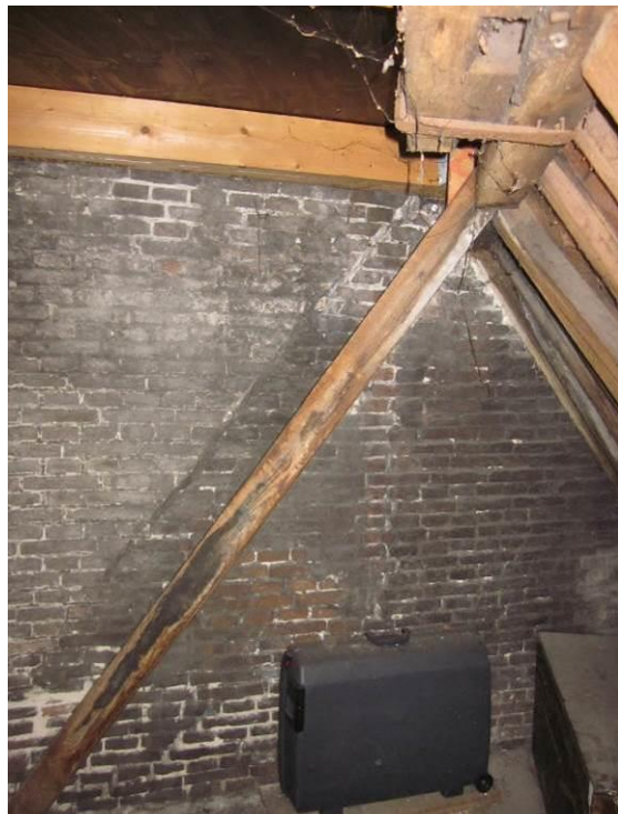
Brouwersgracht 167, zolder. Krommers aan rechterzijde en aftekening oude daklijn tegen voorgevel (foto's David Derksen/ Monumenten en Archeologie).
