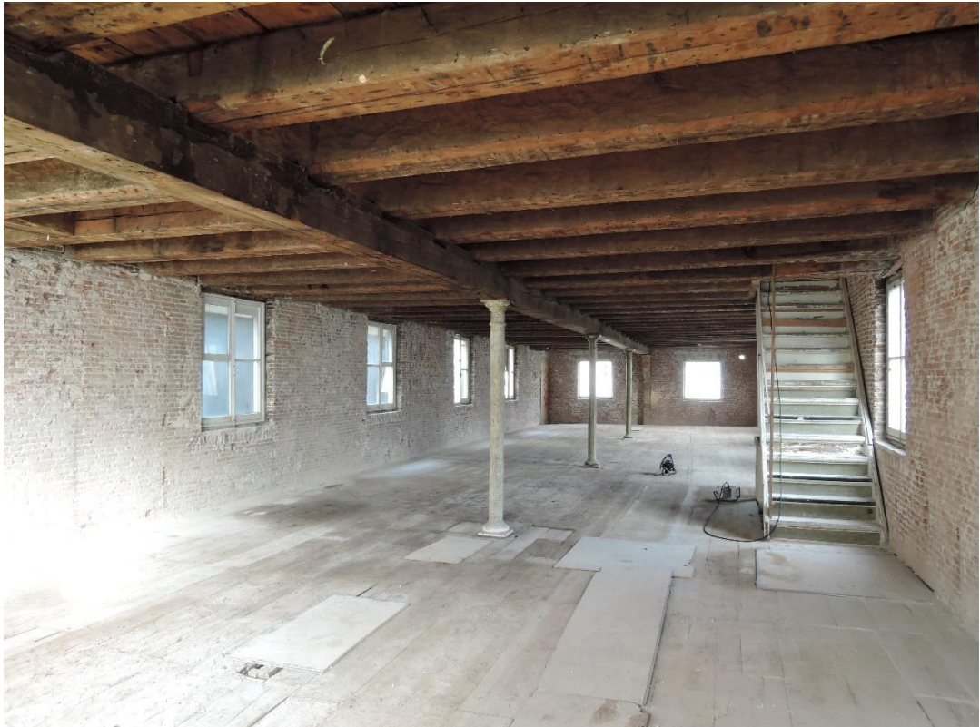
Spuistraat 199, tweede verdieping in 2016 (foto auteur).
