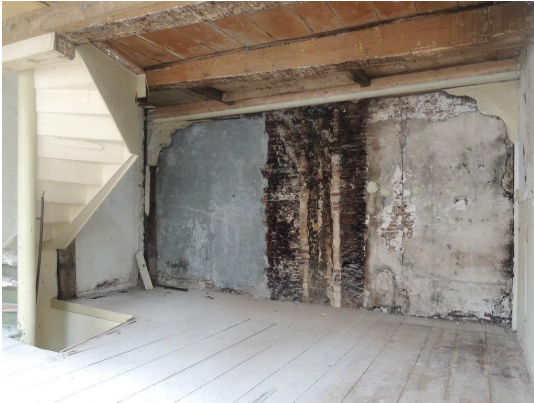
Spuistraat 61, eerste verdieping gezien richting achtergevel (foto auteur).
