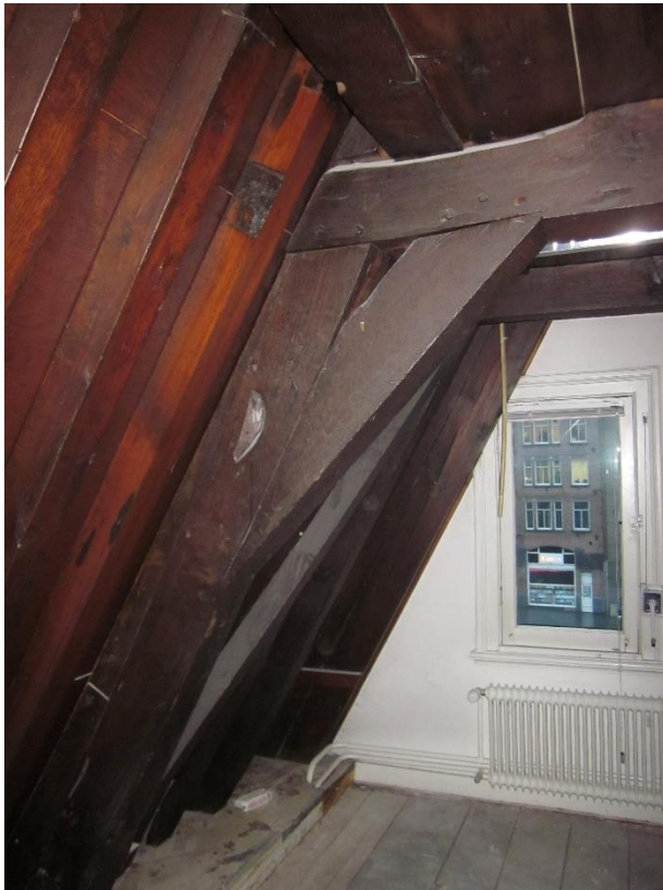
Oude Turfmarkt 147, dekbalkspant en spoor van houtvlotverbinding (foto's auteur).
