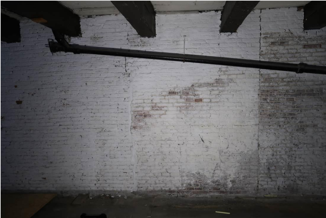
Brouwersgracht 167, eerste verdieping met verticale bouwnaad in rechter zijmuur (foto David Derksen/ Monumenten en Archeologie).
