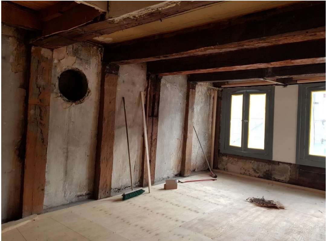
Interieur van de tweede verdieping met houtskelet (foto Miguel van Schoonhoven, 2018).
