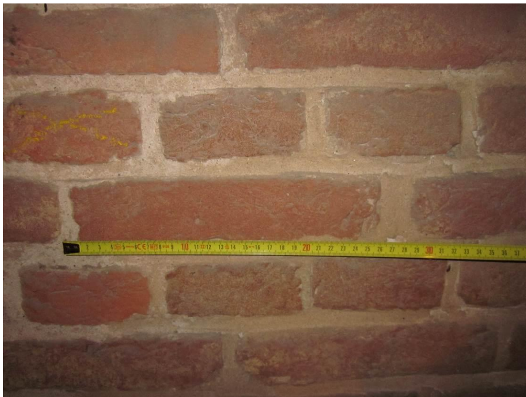
Zandstraat 17, Zuiderkerkstoren, hergebruikte baksteen van de stadsmuur (foto auteur).
