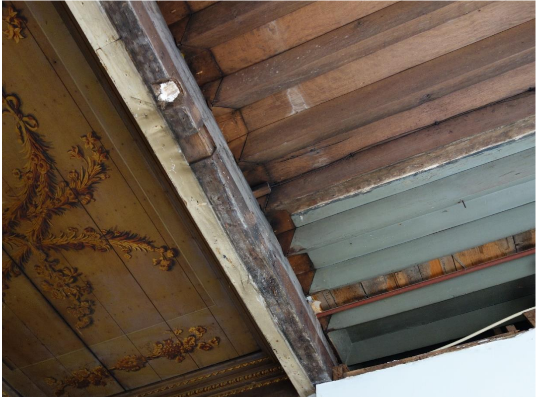
Singel 284, driehoekige kinderbinten in de voorkamer en een deel van het beschilderde plafond in de vroegere achterkamer (foto David Derksen/ Monumenten en Archeologie).
