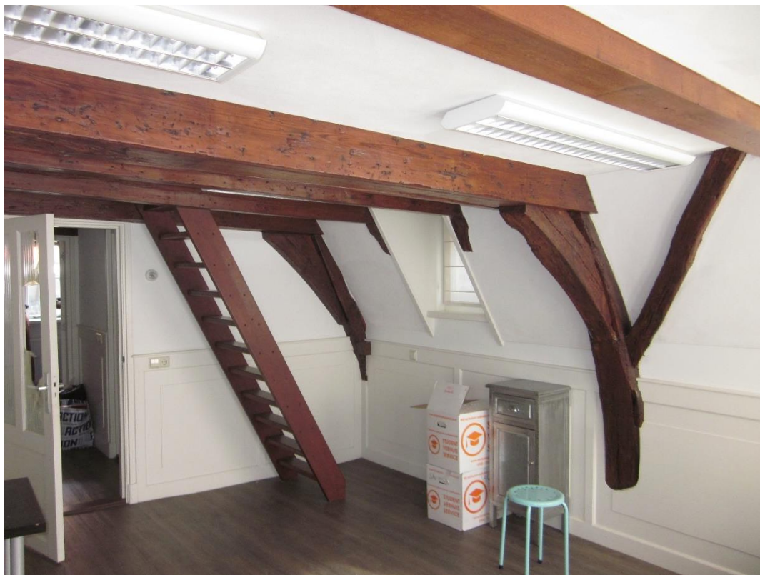
Oudebrugsteeg 8, eikenhouten kapconstructie in het voorhuis, met opgeklampte dekbalken en gekraste telmerken (foto auteur).
