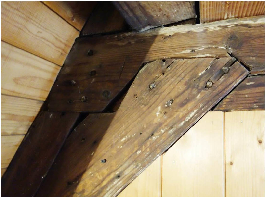
Oudebrugsteeg 6, kapconstructie: halfhoutse verbinding van korbeel en dekbalk (Monumenten en Archeologie).
