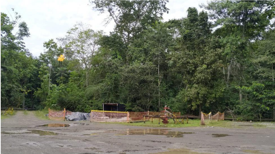
Figura 14. Campo petrolero a la entrada de la Comunidad San Carlos. Fuente: Datos de campo
