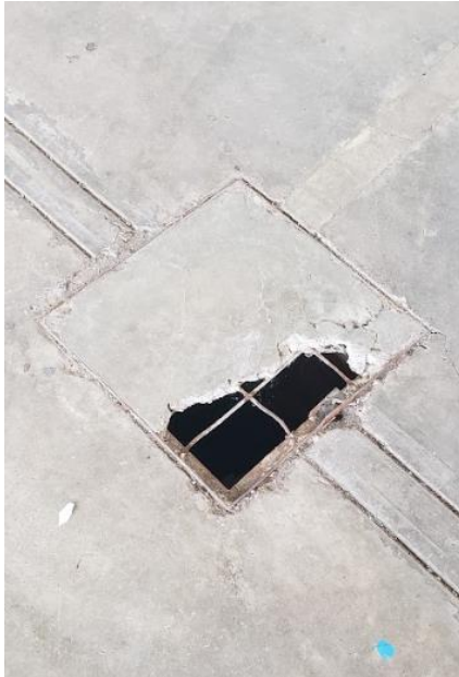
Figura 38.- Tapas de registros rotas. Imagen propiedad del autor.
