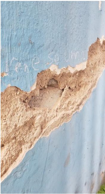
Figura 46.- Muros ranurados. Imagen propiedad del autor.
