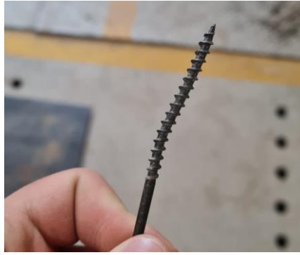
Figura 20. Deformación de pija ubicada en diagonales donde se presentó la falla. Imagen propiedad del autor.
