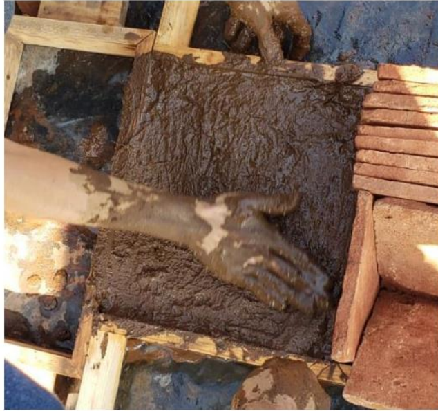
Mezcla siendo colocada en el molde
