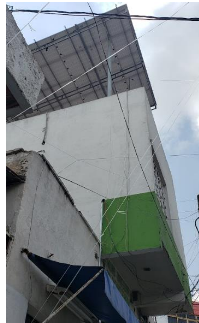
Figura 48.- Segundo piso agregado con el tiempo. Imagen propiedad del autor.
