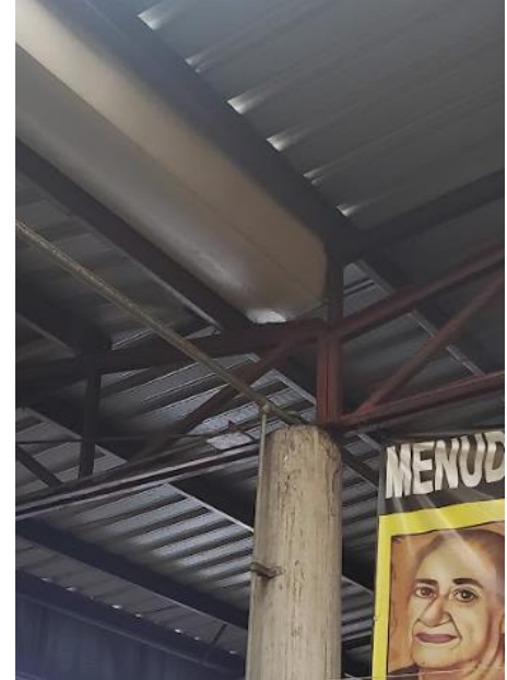
Figura 40.- Excentricidades en apoyos. Imagen propiedad del autor.
