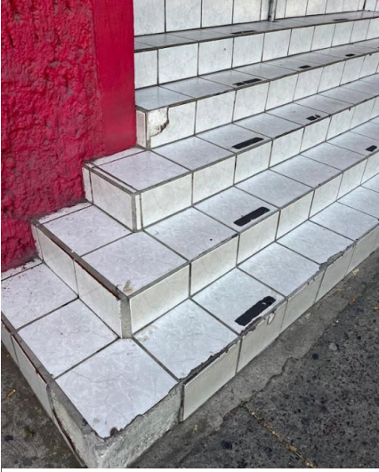
Figura 55.- Escalones sin mosaico y sin cinta antiderrapante. Imagen propiedad del autor.
