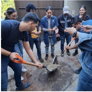
Imagen 3.- Mezcla de la tierra, la fibra y cal
