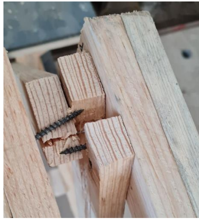
Figura 21. Falla por aplastamiento en diagonal debido a conexión a base de pijas. Imagen propiedad del autor.
