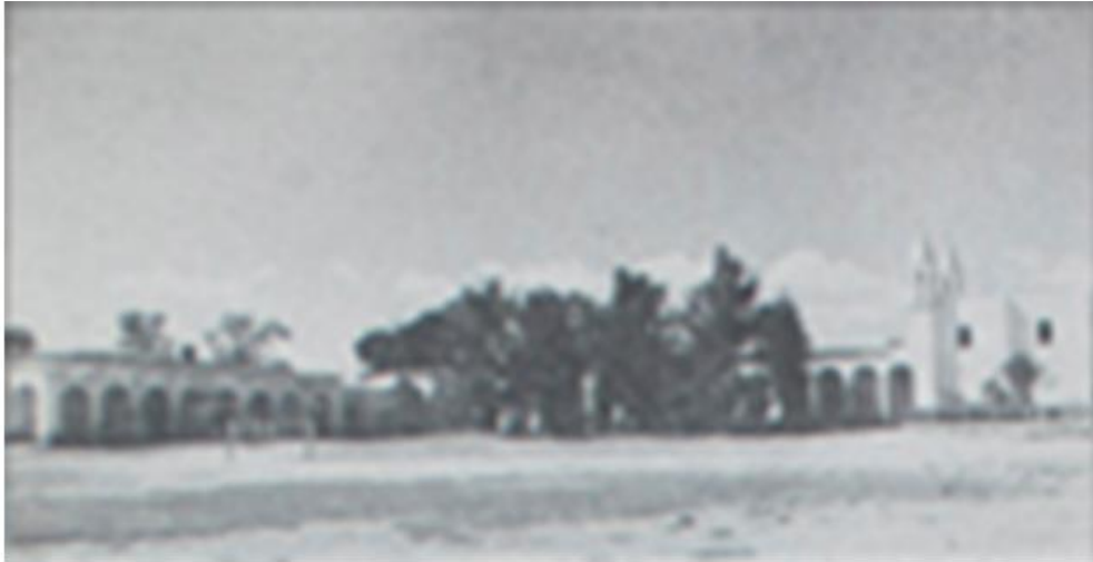
Fachada principal. Foto por: Coordinación gral. de patrimonio UdeG
