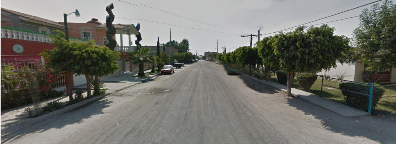
Estado Actual calle Hidalgo.
