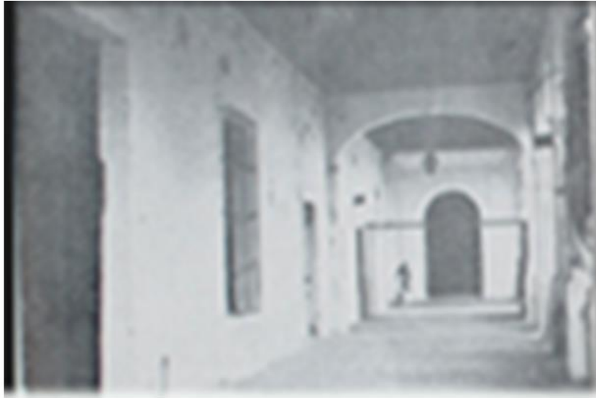
Portal ppal. e ingreso a capilla. Foto por: Coordinación gral. de patrimonio UdeG
