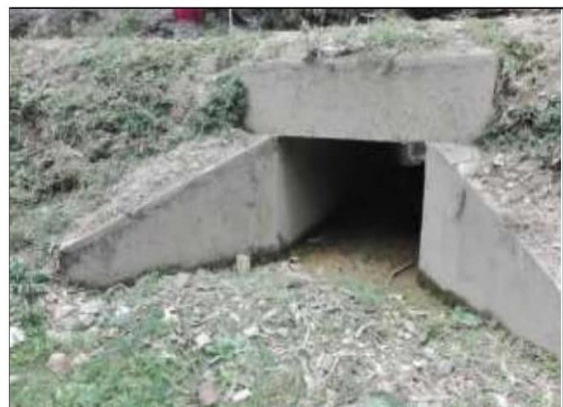
Fotog. Progresiva: 31+489,00 - 31+489,00 72 SALIDA DE LA ALCANTARILLA, EN BUEN ESTADO ESTRUCTURAL SEMI OBSTRUIDA, TIENE ALEROS.
