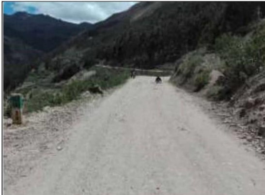
Fotog. Progresiva: 29+071,00 - 29+071,00 45 HITO KILOMETRICO Nº5 LADO IZQUIERDO ANCHO DE VIA:
