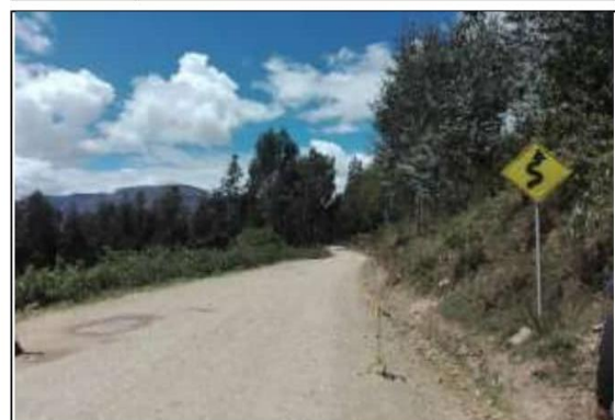
Fotog. Progresiva: 27+152,00 - 27+152,00 30 SEÑAL PREVENTIVA Nº2 LADO DERECHO ANCHO DE VIA: 3.90M
