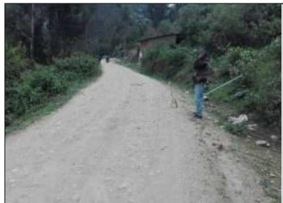
Fotog. Progresiva: 30+024,00 - 30+024,00 48 VISTA PANORÁMICA DE LA TAJEA Nº3 DE PIEDRA DIMENSIONES:3.00M
