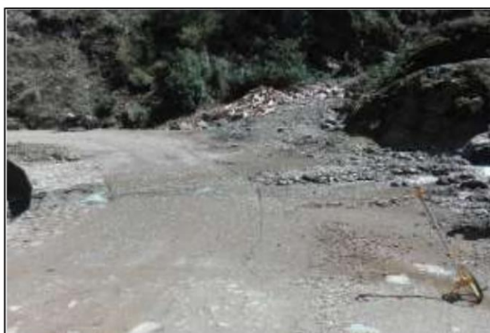
Fotog. Progresiva: 26+298,00 - 28+318,00 23 VISTA PANORAMICA DEL BADEN Nº1 DE CONCRETO DIMENSIONES: L= 10M, A= 4.8M
