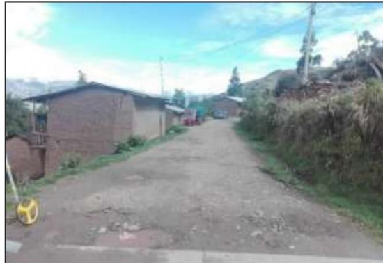
Fotog. Progresiva: 24+046,00 - 24+046,00 1 INICIO DEL TRAMO EN ESTUDIO DE LA CARRETERA HU-101
