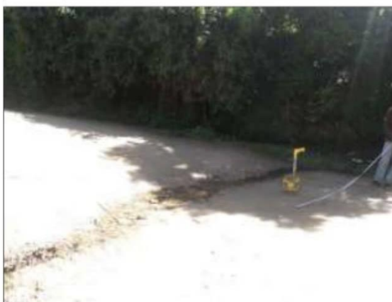
Fotog. Progresiva : 25+776,00 - 25+780,00 35 Se observa la medición del " CRUCE DE AGUA " en el punto más crítico.
