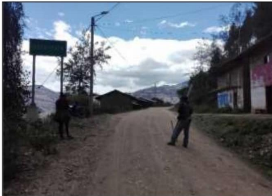
Fotog. Progresiva: 31+944,00 - 31+944,00 85 SEÑAL INFORMATIVA Nº3 LADO IZQUIERDO ANCHO DE VIA:3.30M
