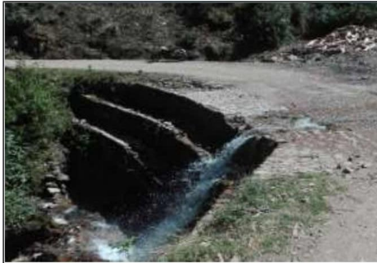
Fotog. Progresiva: 26+298,00 - 28+318,00 25 SE OBSERVA AGUA ABAJO FLUYE EL AGUA CON NORMALIDAD, REGULAR ESTADO ESTRUCTURAL
