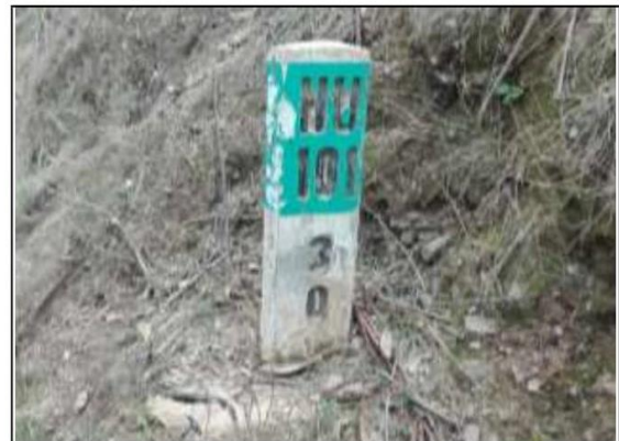
Fotog. 52 Progresiva: 30+246,00 - 30+246,00 HITO KILOMETRICO N°6 LADO DERECHO, EN BUEN ESTADO ESTRUCTURAL, VISIBILIDAD MALA.
