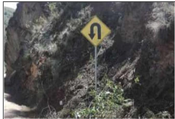
Fotog. Progresiva: 26+403,00 - 26+403,00 28 SEÑAL PREVENTIVA Nº1 LADO DERECHO, EN BUEN ESTADO ESTRUCTURAL , BUENA VISIBILIDAD.
