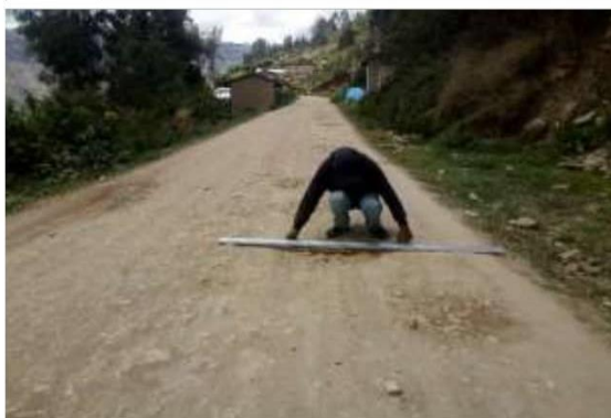
Fotog. Progresiva : 32+287,00 - 32+500,00 131 Se observa la medición del " BACHRES " en el punto más crítico.
