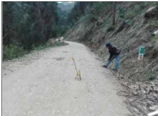
Fotog. 51 Progresiva: 30+246,00 - 30+246,00 HITO KILOMETRICO N°6 LADO DERECHO ANCHO DE VIA: 3.50M
