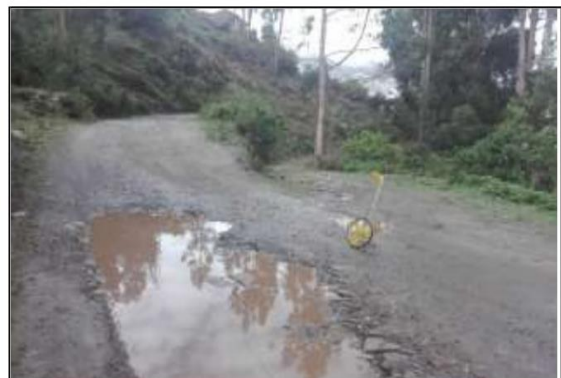
Fotog. Progresiva: 24+229,00 - 24+229,00 6 VISTA ATRÁS DEL DESVIO HACIA MUNJUN
