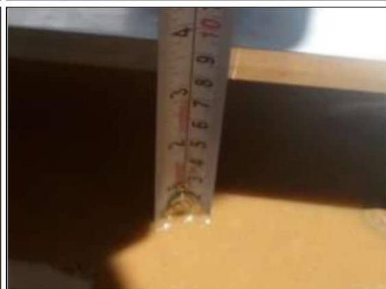
Fotog. Progresiva : 29+500,00 - 30+000,00 96 Se observa que el " BACHRES " Tiene: 11,00 cm Considerado como: NG: 3
