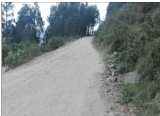
Fotog. Progresiva: 31+786,00 - 31+786,00 81 TAJEA N°4 DE PVC, VISTA PANORÁMICA DIMENSIONES: L=3.4M , A=0.8M, H=0.65M
