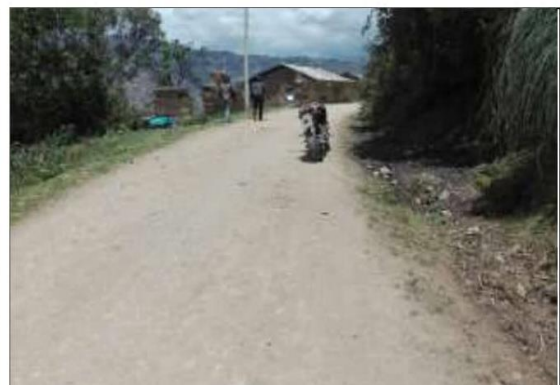
Fotog. Progresiva: 28+165,00 - 28+165,00 42 VISTA PANORÁMICA DE LA TAJEA Nº2 DE PIEDRA DIMENSIONES: L=3.2M, A=0.1M, H0.1M
