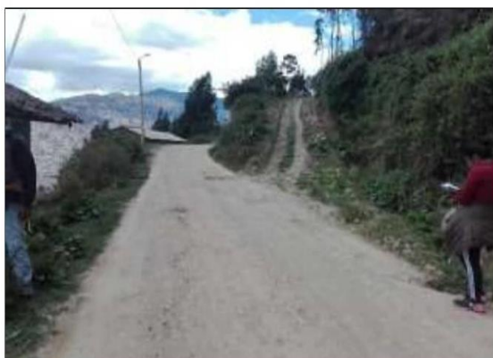
Fotog. Progresiva: 32+005,00 - 32+005,00 95 DESIVIO
