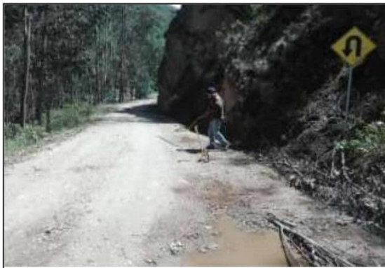
Fotog. Progresiva: 26+403,00 - 26+403,00 27 SEÑAL PREVENTIVA Nº 1 LADO DERECHO ANCHO DE VIA: 3.50M
