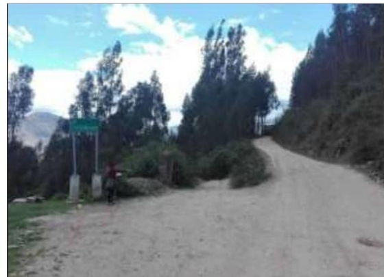
Fotog. Progresiva: 31+776,00 - 31+776,00 76 SEÑAL INFORMATIVA Nº2 LADO IZQUIERDO ANCHO DE VIA: 3.60M
