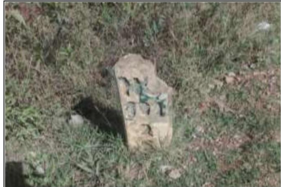
Fotog. Progresiva: 25+042,00 - 25+042,00 14 HITO KILOMETRICO Nº2 EN MAL ESTADO ESTRUCTURAL VISIBILIDAD MALA
