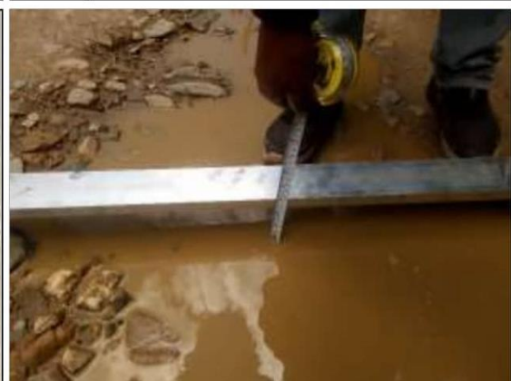
Fotog. Progresiva : 31+270,00 - 31+500,00 120 Se observa que el " BACHRES " Tiene: 0,09 cm Considerado como: NG: 2
