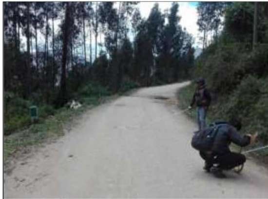
Fotog. Progresiva: 31+250,00 - 31+250,00 67 HITO KILOMETRICO N°7 LADO IZQUIERDO ANCHO DE VIA : 3:20M
