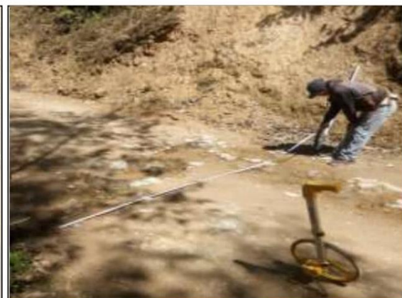
Fotog. Progresiva : 26+500,00 - 26+502,00 54 Se observa que el " CRUCE DE AGUA " Tiene: 0,00 cm Considerado como: NG: 1
