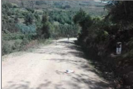
Fotog. Progresiva: 26+048,00 - 26+048,00 19 HITO KILOMETRICO Nº3 LADO DERECHO ANCHO DE VIA: 3.80M
