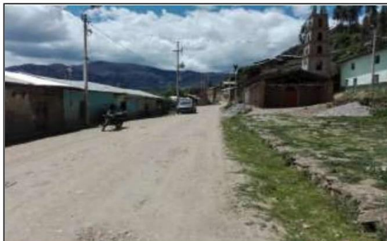
Fotog. Progresiva: 33+000,00 - 33+000,00 105 FINAL DEL TRAMO EN ESTUDIO DE LA CARRETERA DEPARTAMENTAL HU-101
