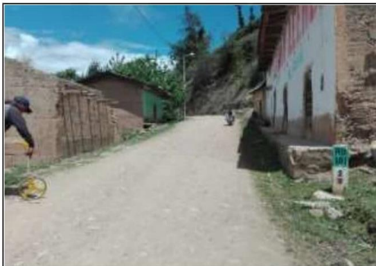
Fotog. Progresiva: 28+086,00 - 28+086,00 39 HITO KILOMETRICO Nº4 LADO DERECHO ANCHO DE VIA: 3.00 M
