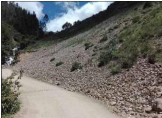
Fotog. 61 Progresiva: 31+053,00 - 31+134,00 CUNETETA DE TIERRA LADO DERECHO, OBSTRUIDA EN UN 100% ANCHO DE VIA: 3.20M
