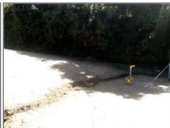
Fotog. Progresiva : 25+776,00 - 25+780,00 36 Se observa que el " CRUCE DE AGUA " Tiene: 0,00 cm Considerado como: NG: 1
