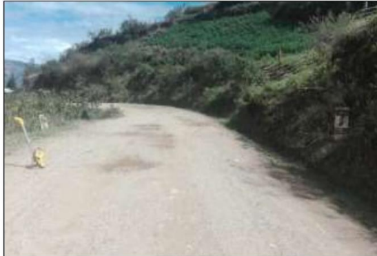
Fotog. Progresiva: 25+042,00 - 25+042,00 13 HITO KILOMETRICO Nº 2 UBICADO AL LADO IZQUIERDO ANCHO DE VIA: 4.20M
