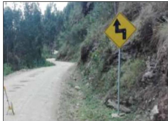
Fotog. Progresiva: 31+494,00 - 31+494,00 74 SEÑAL PREVENTIVA LADO DERECHO, EN BUEN ESTADO ESTRUCTURAL, BUENA VISIBILIDAD.
