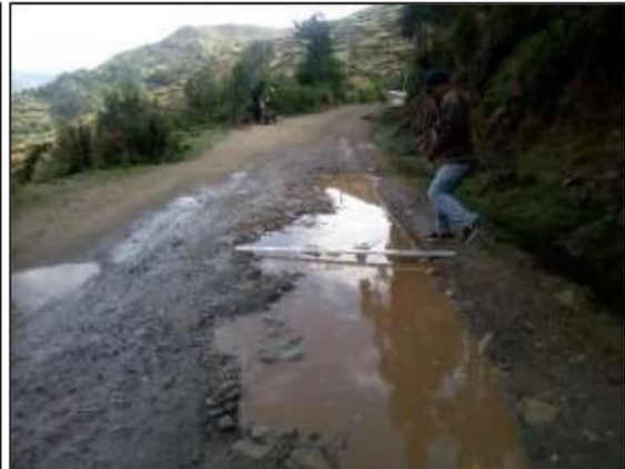
Fotog. Progresiva : 24+223,00 - 24+500,00 14 Se observa la medición del " BACHES " en el punto más crítico.
