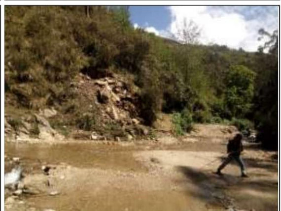
Fotog. Progresiva : 26+385,00 - 26+387,00 48 Se observa que el " CRUCE DE AGUA " Tiene: 0,00 cm Considerado como: NG: 1
