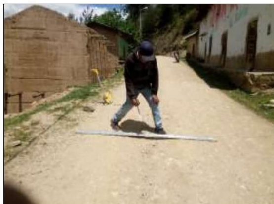
Fotog. Progresiva : 28+076,00 - 28+165,00 83 Se observa la medición del " EROSIÓN " en el punto más crítico.
