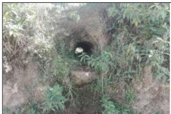
Fotog. Progresiva: 25+210,00 - 25+210,00 18 SALIDA DE LA ALCANTARILLA LIMPIA, NO TIENE ALEROS
