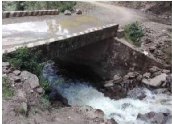
Fotog. 64 Progresiva: 31+134,00 - 31+145,00 VISTA AGUAS ARRIBA, ESTRUBOS EN REGULAR ESTADO ESTRUCTURAL.
