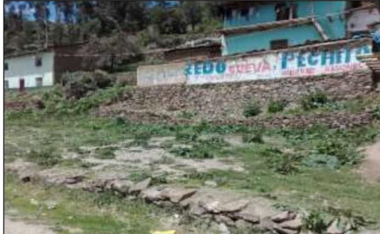
Fotog. Progresiva: 32+720,00 - 32+720,00 103 PLAZA DE LA LOCALIDAD DE QUEROPATA
