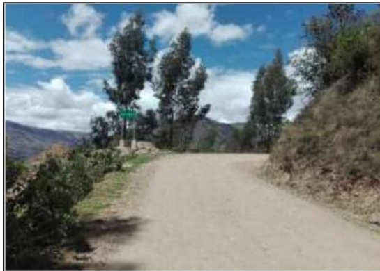
Fotog. 33 Progresiva: 27+335,00 - 27+335,00 SEÑAL INFORMATIVA Nº1 LADO IZQUIERDO ANCHO DE VIA: 5.00M
