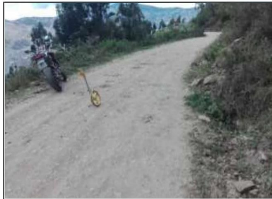
Fotog. Progresiva: 32+063,00 - 32+063,00 97 TAJEA Nº 6 DE PIEDRA, VISTA PANORÁMICA DIMENSIONES: L=3.00M, A=0.6M, H=0.3M
