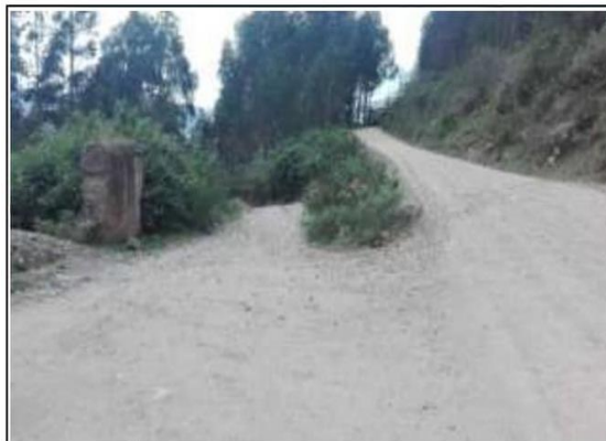
Fotog. Progresiva: 31+782,00 - 31+782,00 79 DESVIO AL LADO IZQUIERDO HACIA LA LOCALIDAD DE CHUQUIBAMBA.
