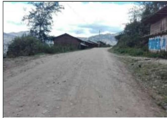
Fotog. Progresiva: 31+944,00 - 31+944,00 88 INICIO DE LA LOCALIDAD DE QUEROPATA
