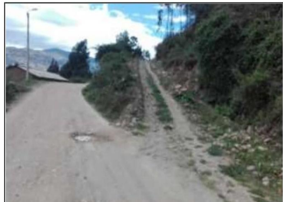
Fotog. Progresiva: 32+005,00 - 32+005,00 94 DESIVIO AL LADO DERECHO HACIA EL GRASS SINTETICO DE QUEROPATA.
