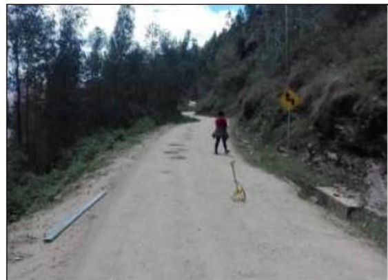
Fotog. Progresiva: 31+489,00 - 31+489,00 70 ALCANTARILLA N°2 TIPO MARCO DIMENSIONES: L=3, A=1.3M, H=0.68M
