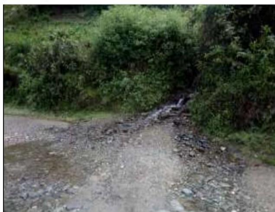
Fotog. Progresiva : 24+505,00 - 24+514,00 17 Se observa la medición del " CRUCE DE AGUA " en el punto más crítico.
