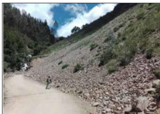
Fotog. Progresiva: 31+053,00 - 31+053,00 60 SE OBSERBA EL ALTO RIESGO EXISTENTE DEBIDO A QUE EL TALUD SUPERIOR SE DESLIZA CON FRECUENCIA YA QUE ES DE MATERIAL DE GRABA
