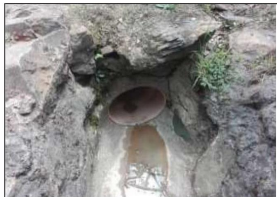
Fotog. Progresiva: 31+786,00 - 31+786,00 82 ENTRADA DE LA TAJEA LIMPIA , EN BUE ESTADO ESTRUCTURAL.
