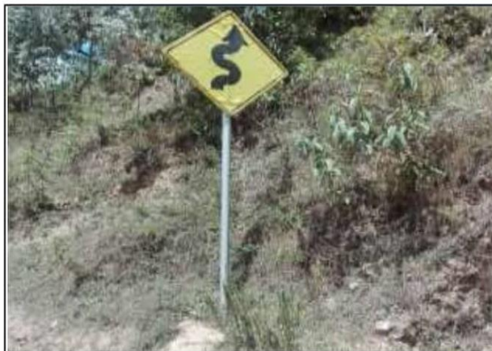
Fotog. 31 Progresiva: 27+152,00 - 27+152,00 SEÑAL PREVENTIVA Nº 2 LADO DERECHO, BUEN ESTADO ESTRUCTURAL, VISIBILIDAD REGULAR
