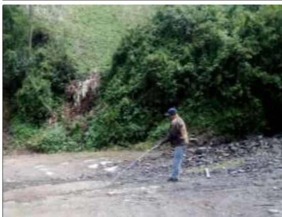
Fotog. Progresiva : 24+693,00 - 24+698,00 23 Se observa la medición del " CRUCE DE AGUA " en el punto más crítico.
