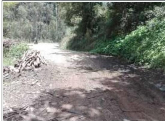
Fotog. Progresiva: 30+614,00 - 30+624,00 55 BADEN Nº2 DECONCRETO VISTA PANORAMICA DIMENSIONES: L= 10M, A= 3.50M
