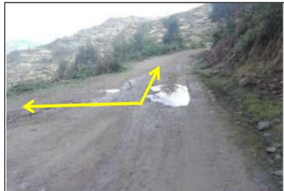
Fotog. Progresiva: 24+229,00 - 24+229,00 4 DESVIO AL LADO IZQUIERDO HACIA LA LOCALIDAD DE MUNJUN ANCHO DE VIA: 4.50M
