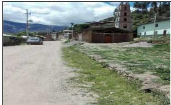
Fotog. Progresiva: 33+000,00 - 33+000,00 106 CUNETETA DE TIERRA LADO DERECHO, OBSTRUIDA EN UN 15% ANCHO DE VIA: 4.90M
