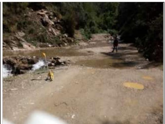
Fotog. Progresiva : 26+385,00 - 26+387,00 46 Verificación de deterioro en la calzada generado por la existencia de " CRUCE DE AGUA ", ancho de plataforma 5.6 m.
