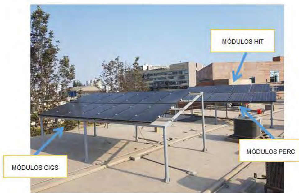
Fig. 2-2: Instalaciones para el ensayo
